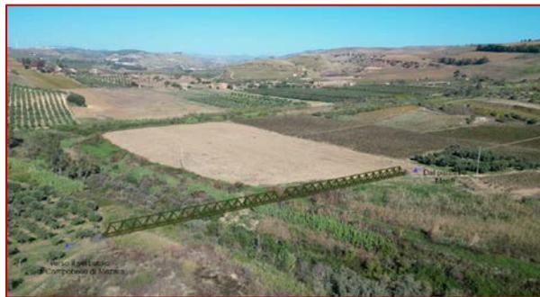
L'attraversamento aereo è stato limitato alla sola fascia della pertinenza fluviale, che prevede nella zona di attraversamento un'ampiezza di m 125.50 circa. Infatti a fronte di una fascia di esondazione con TR 200 anni molto ampia (350 m circa), stante le caratteristiche orografiche dei luoghi, la zona di pertinenza delle fluenze ordinarie è limitata a circa 100 m, con la parte restante destinata al normale uso agrario dei suoli, con presenza di uliveti e vigneti.
