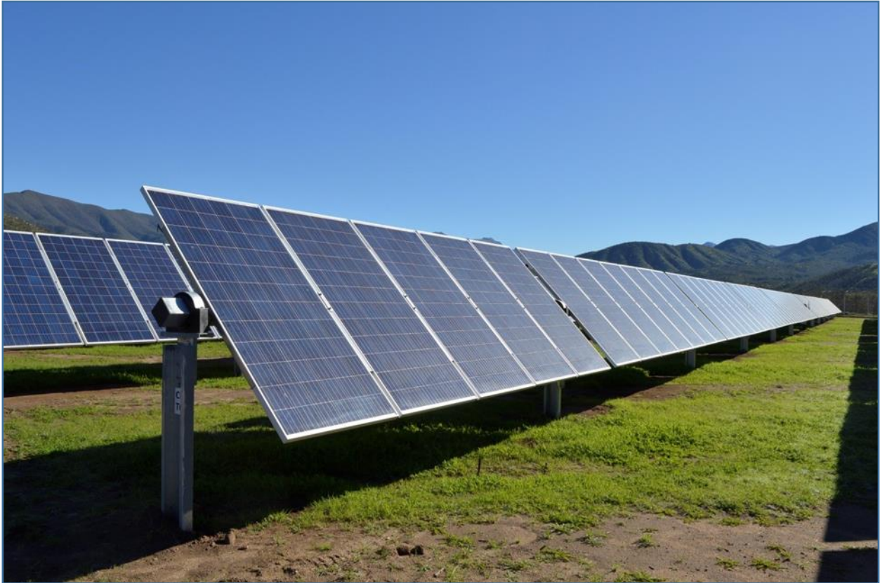
FIGURA 15 – INSTALLAZIONE SU INSEGUITORE MONO ASSIALE CON SINGOLO MODULO
