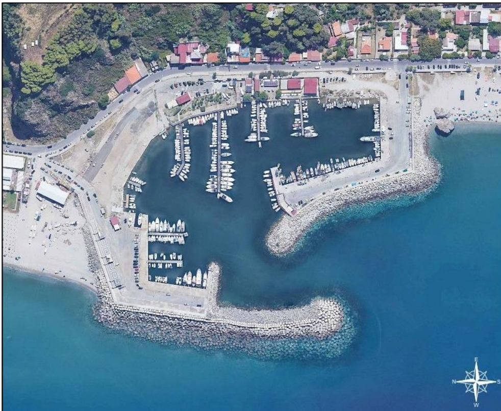
Figura 4.1 - Ortofoto stato di fatto
