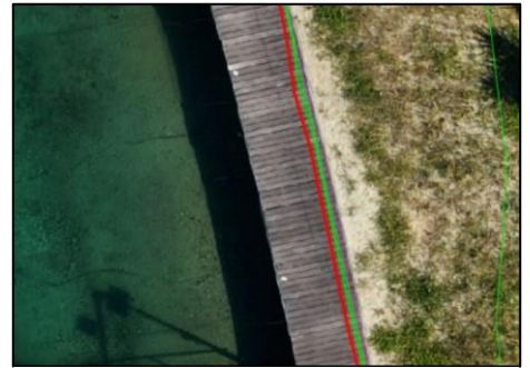
Figura 5.2 - Interferenza tra rilievo e strutture a sbalzo
