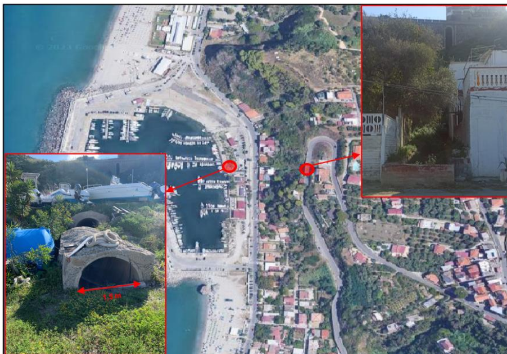
Figura 7.16 - Condotta di scarico acque bianche (dettaglio dello scarico a riva e dell'attraversamento sulla strada soprastante)
