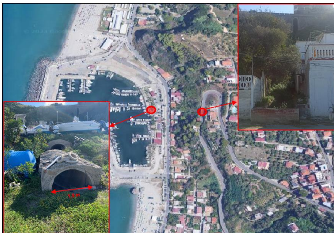
Figura 2.2 - Condotta di scarico acque bianche (dettaglio dello scarico a riva e dell'attraversamento sulla strada soprastante)
