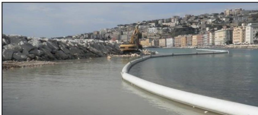
Figura 5-2 Utilizzo delle barriere anti- torbidità durante i lavori
