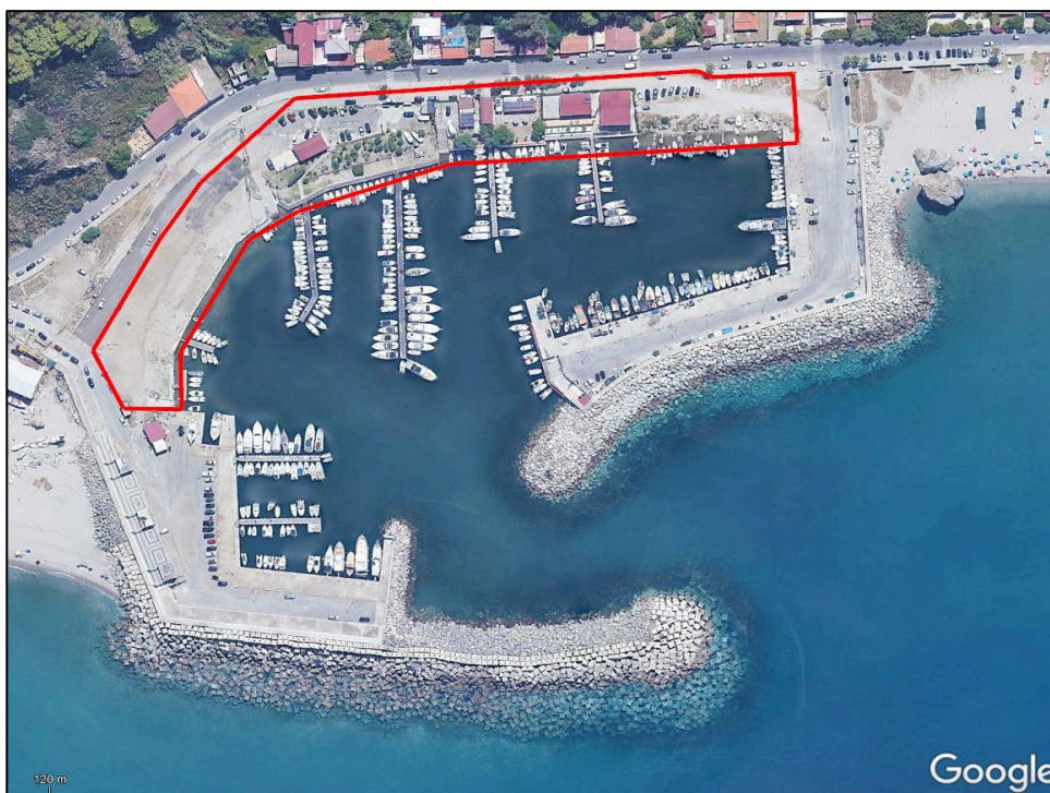
Figura 3-4 Area di intervento - Immagine satellitare (Fonte: Google Earth)
