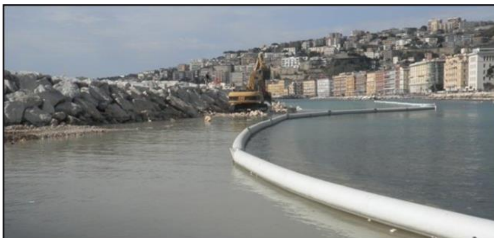
Figura 5-2 Utilizzo delle barriere anti- torbidità durante i lavori
