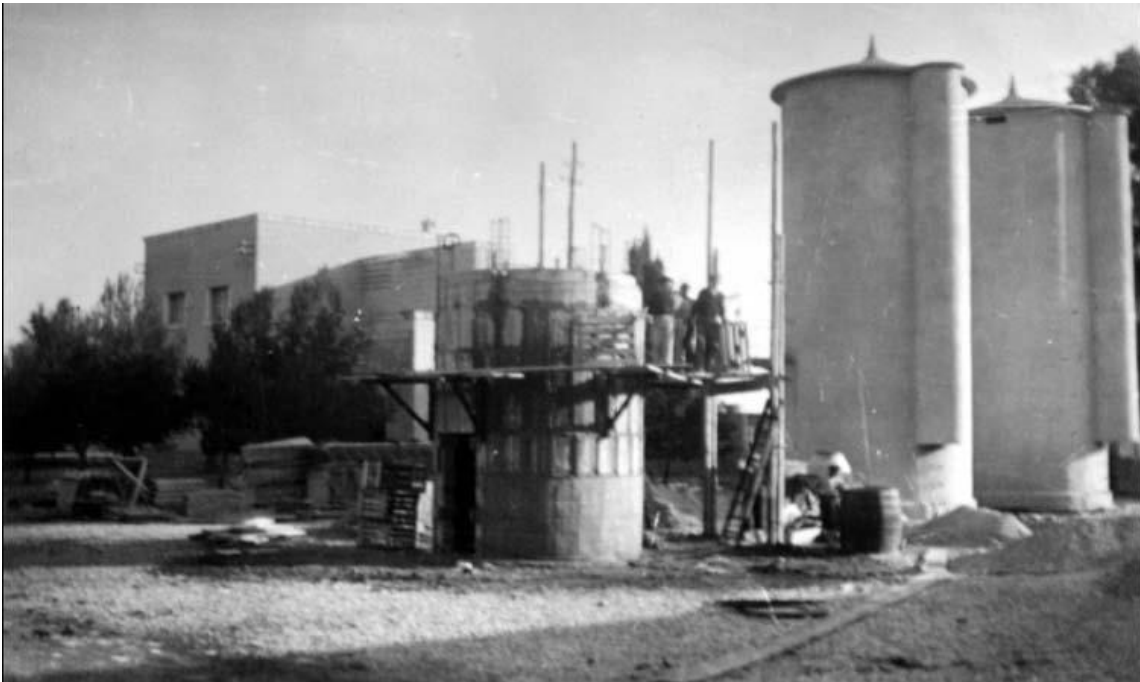
Figura 81 Torrino in corso di costruzione (tratto da https://www.salentoacolory.it/il-borgo-rurale-di-monteruga/ )
