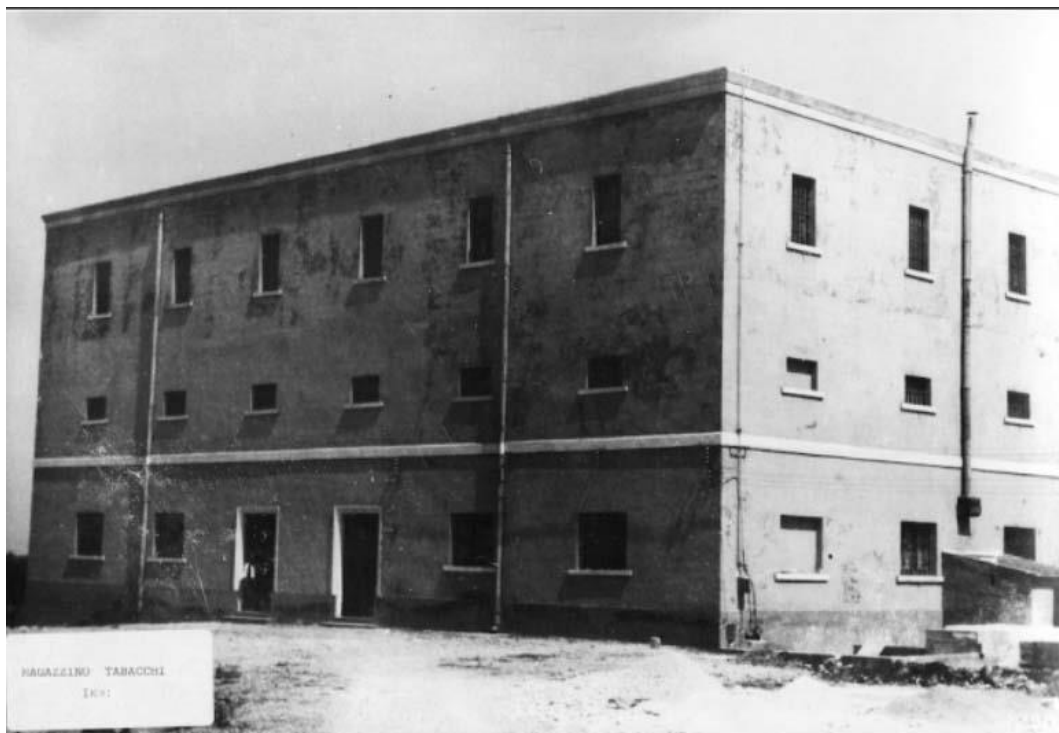
Figura 128 Deposito tabacchi (DISO 2013)
