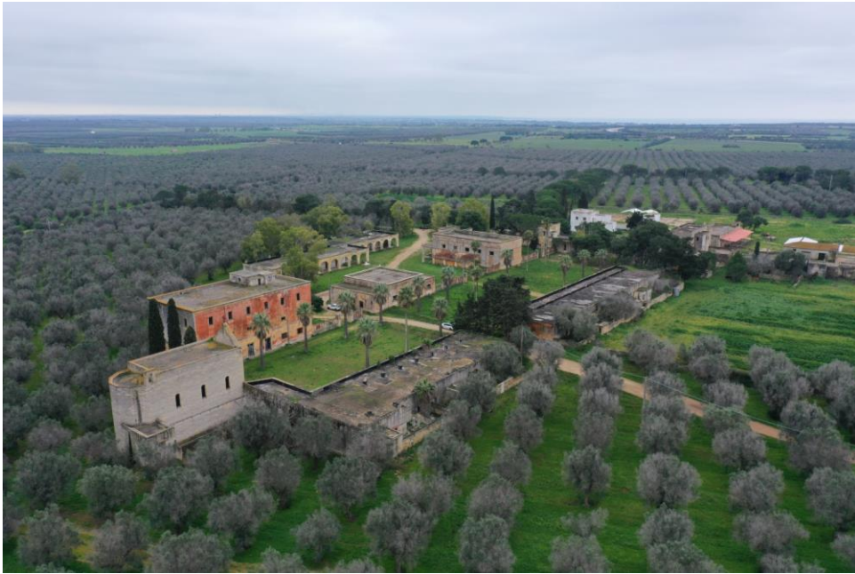
Figura 110 Borgo di Monteruga. Ripresa da drone prima dell'espanto degli ulivi infetti da xylella (dicembre 2022)
