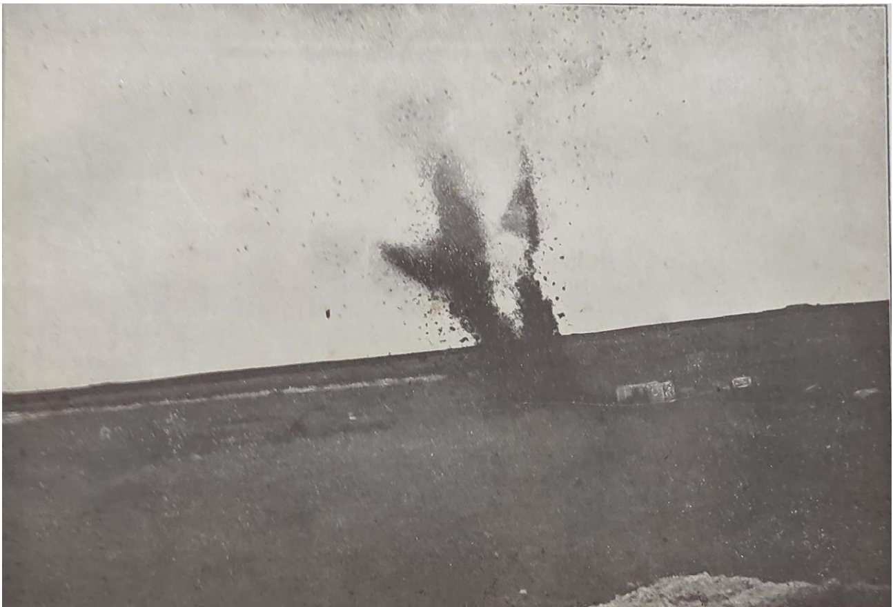
Figura 93 Brillamento di mine per impianto di un frutteto nell'Azienda Monteruga (BIASCO 1932, p.33)
