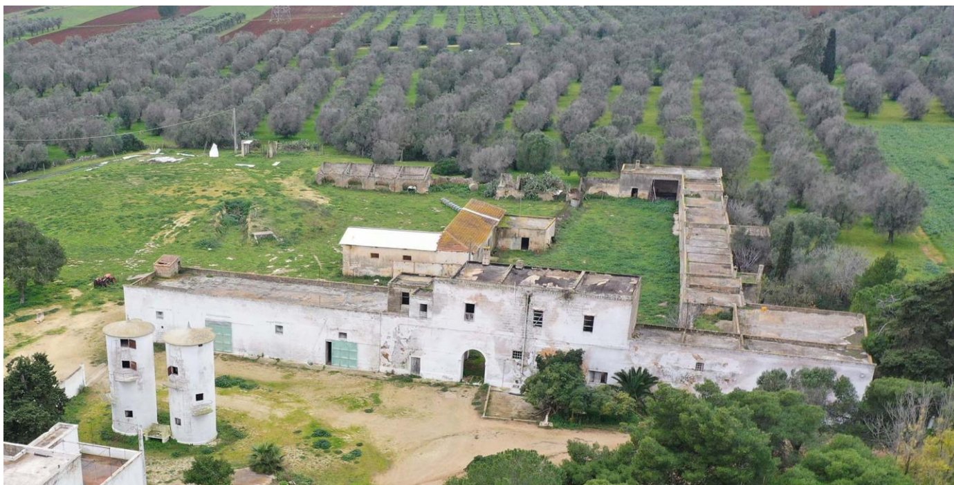
Figura 29 Masseria Monteruga. Ripresa da drone da Est prima dell'espanto degli ulivi infetti da xylella
