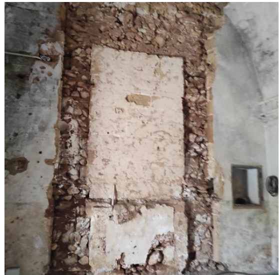
Figura 36 Vano cappella. Tracce in negativo dell'altare
