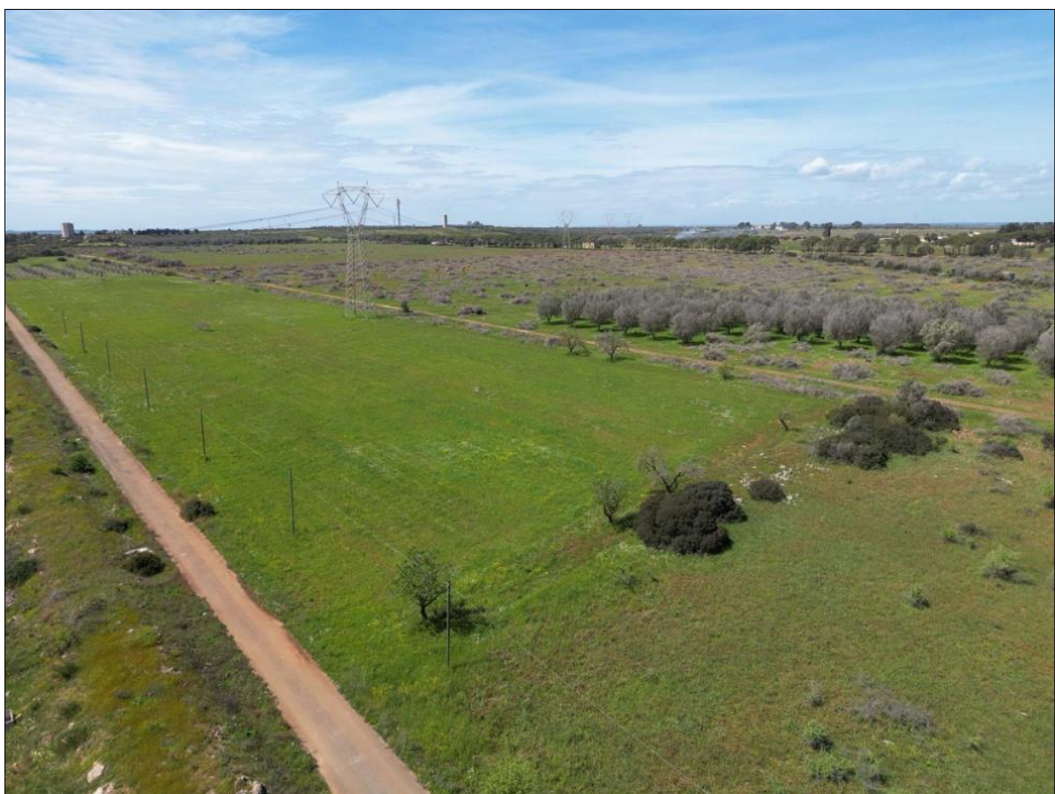
Figura 53 Area Riposo Arneo oggi. Ripresa da drone da Sud-Est
