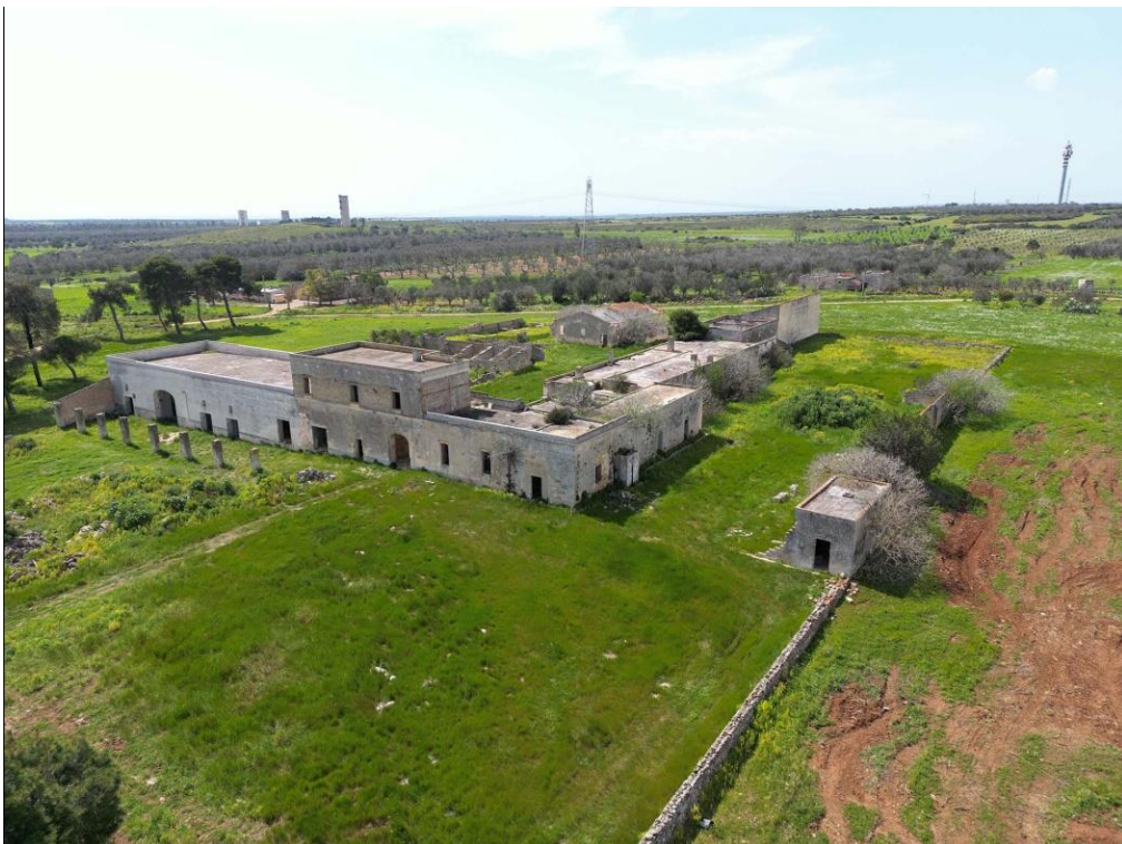
Figura 38 Masseria Ciurli. Ripresa da drone da Est
