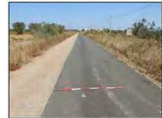
545 Proseguenza cavidotto su strada asfaltata or. N-S
