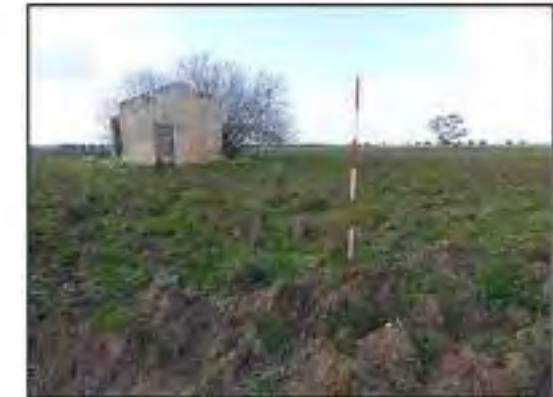
91 Part.Ila 40. Lato W. Vista da Est
