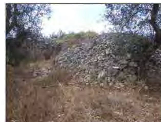
656 Part.Ila 22 Foglio 10 Avetrana. Resti muro a secco
