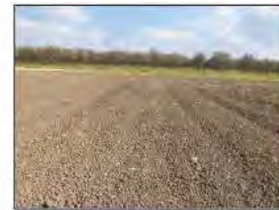
245 Lato Est. Vista da W
