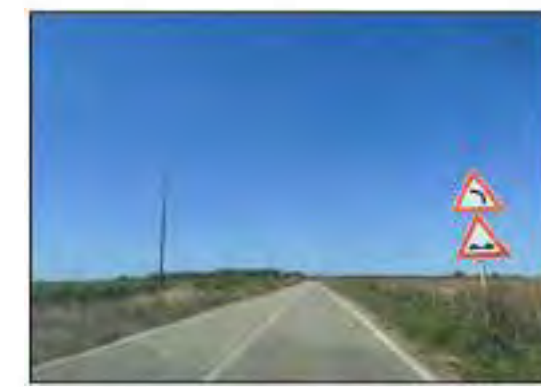
466 Tracciato cavidotto or. E-W su SP 107 in direzione W
