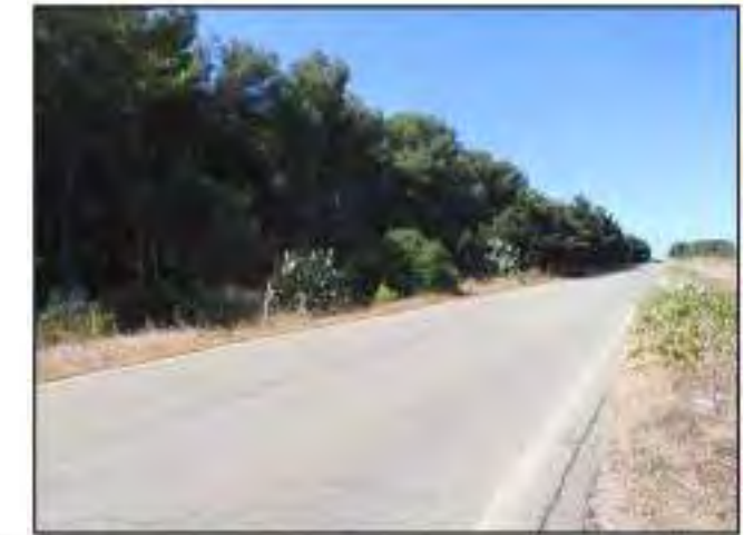
521 prosecuzione tracciato cavidotto or. E-W in direzione W su SP 107
