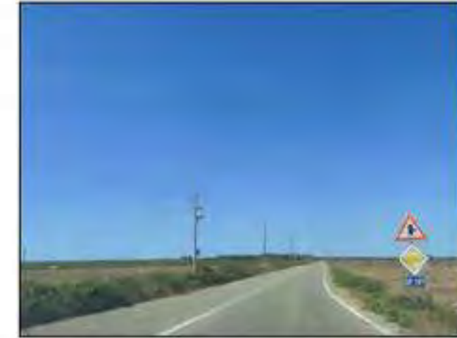
508 prosecuzione tracciato cavidotto or. E-W in direzione W su SP 107
