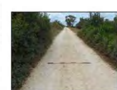
542 Prosecuzione tracciato cavidotto su strada sterrata or. NW-SW
