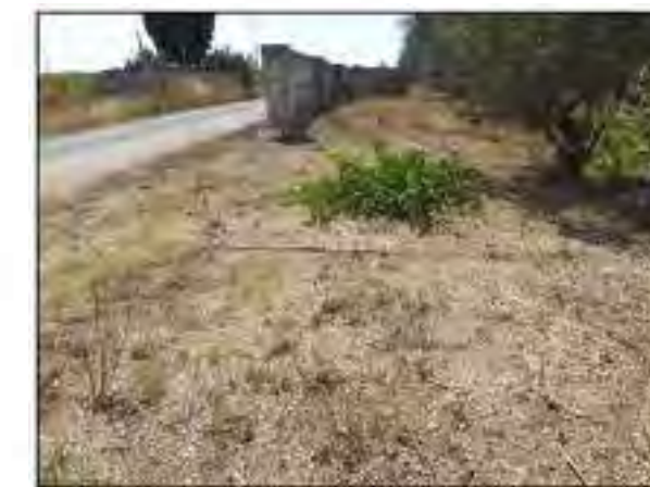
631 Innesto cavidotto in uliveto verso SET Terna Ampliamento. Part.Ila 350 F10 Avetrana
