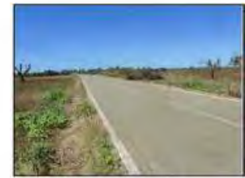
559 prosecuzione tracciato cavidotto or. E-W in direzione W su SP 107
