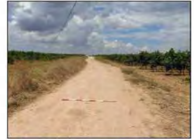
581 prosecuzione tracciato cavidotto su strada sterrata or. NW-SW
