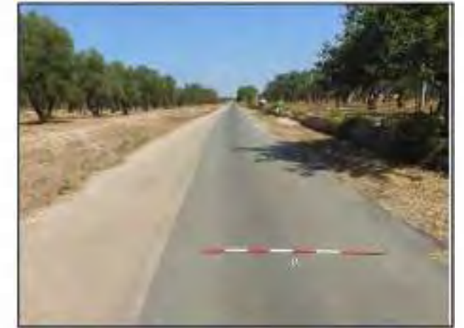
608 Proseguimento cavidotto su strada asfaltata or. N-S
