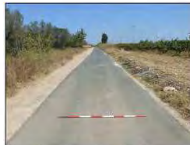
621 prosecuzione cavidotto su strada verso SSE
