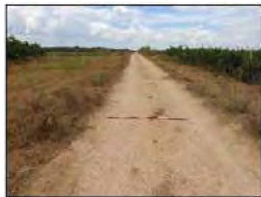
593 prosecuzione tracciato cavidotto su strada sterrata or. NW-SW
