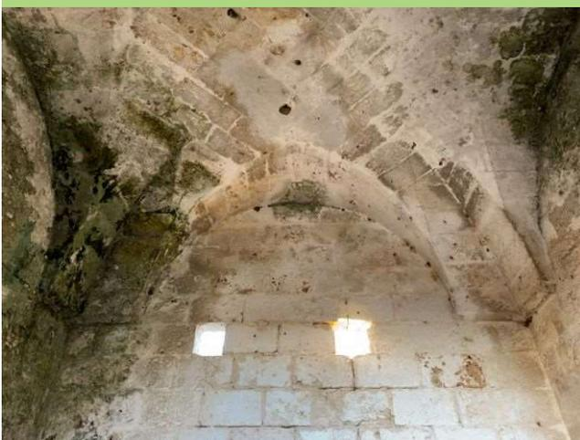
Foto 5. A.1.i - Interno di una casetta appoggio, particolare di volta a stella.
