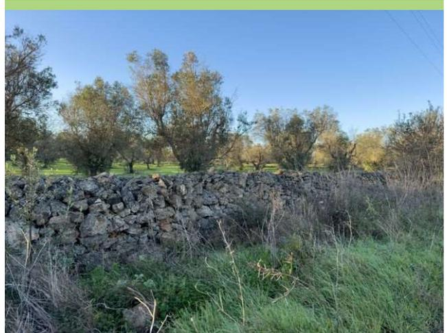
Foto 26. B.5.p - Muro a secco.
