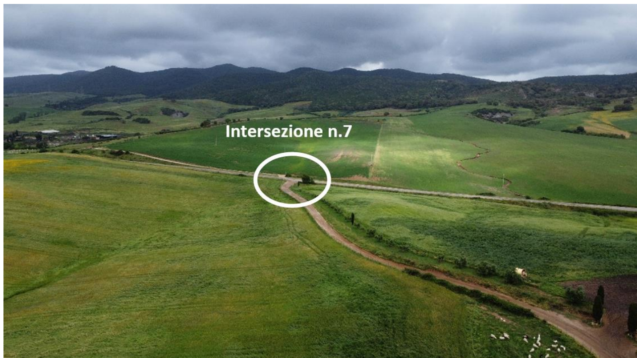
Figura 2. Intersezione n.7 del punto di attraversamento della viabilità provinciale in T.O.C. (da drone)
