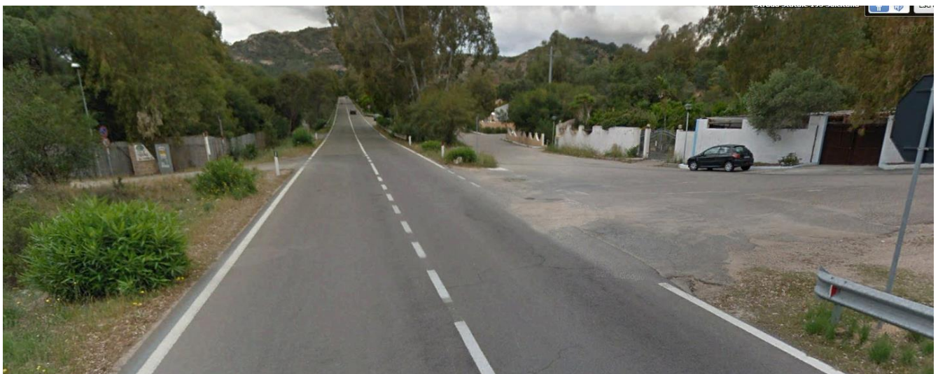
Figura 7 - Intersezione al km 41+200, vista da SS 195 (direzione Teulada)
