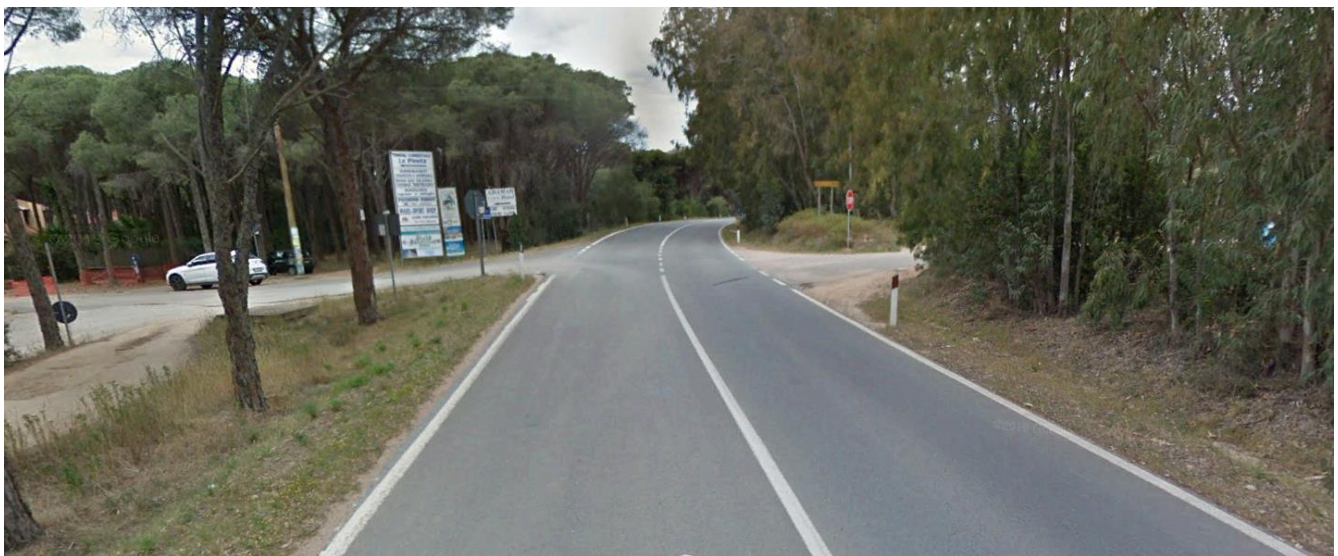
Figura 4 - Intersezione km 39+800, vista da SS 195 (direzione Teulada)
