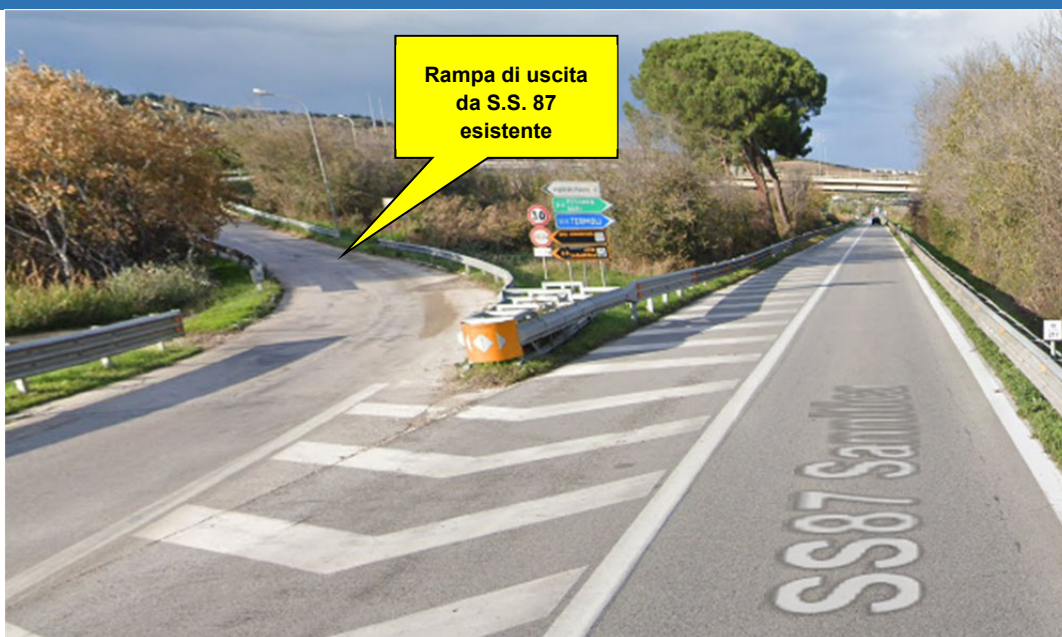
Figura 5.2 – Rampa di uscita da S.S. 87 esistente
