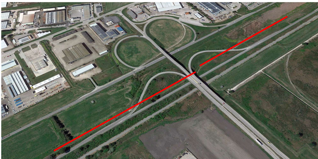
Figura 2.2 – Vista dall'alto della S.S. 87 e del canale (rosso)
