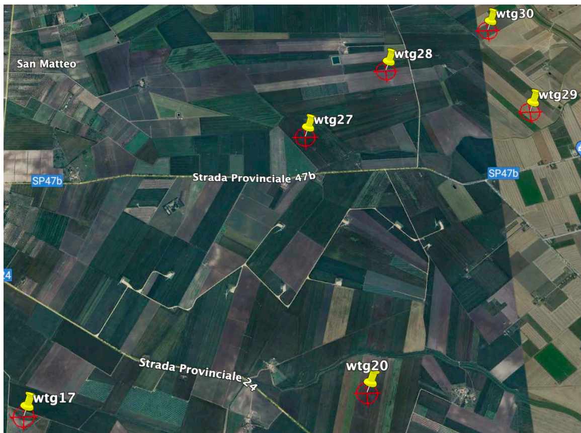
Impianto siglato 3ONDO95 costituito da 10 torri (si osservano al centro della ortofoto)
