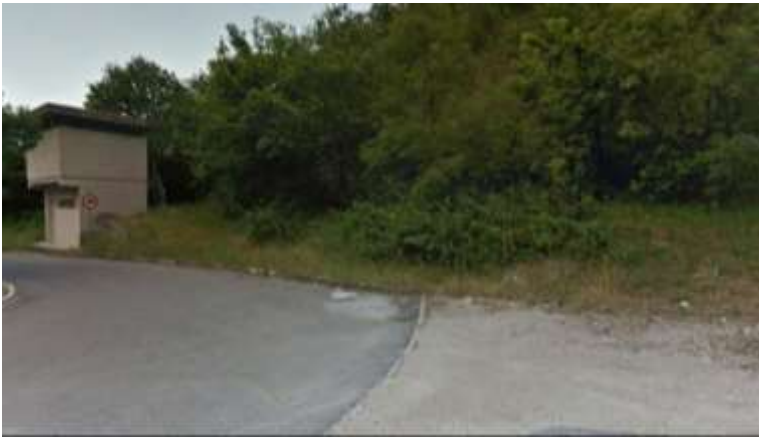
Figura 25: Area di ubicazione nuova cabina elettrica.
