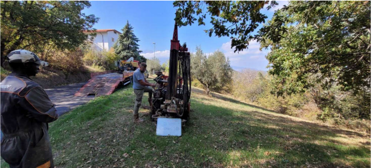
Foto n.12 - Postazione sondaggio S10
