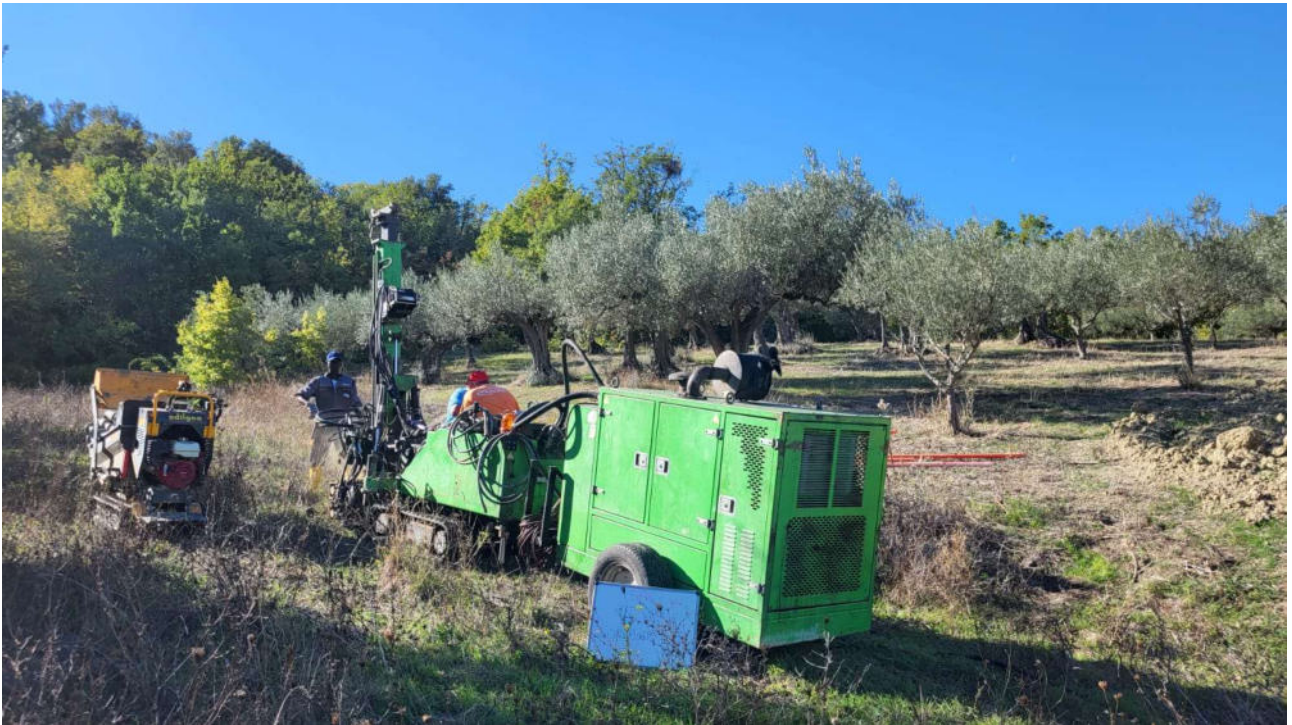
Foto n.1 - Postazione sondaggio S5
