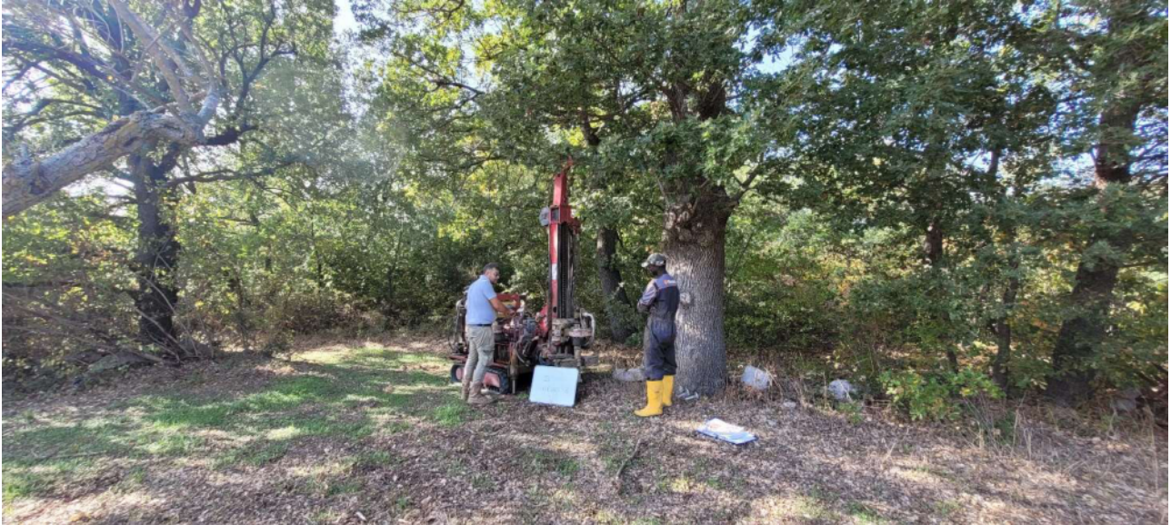
Foto n.4 -Postazione sondaggio S6
