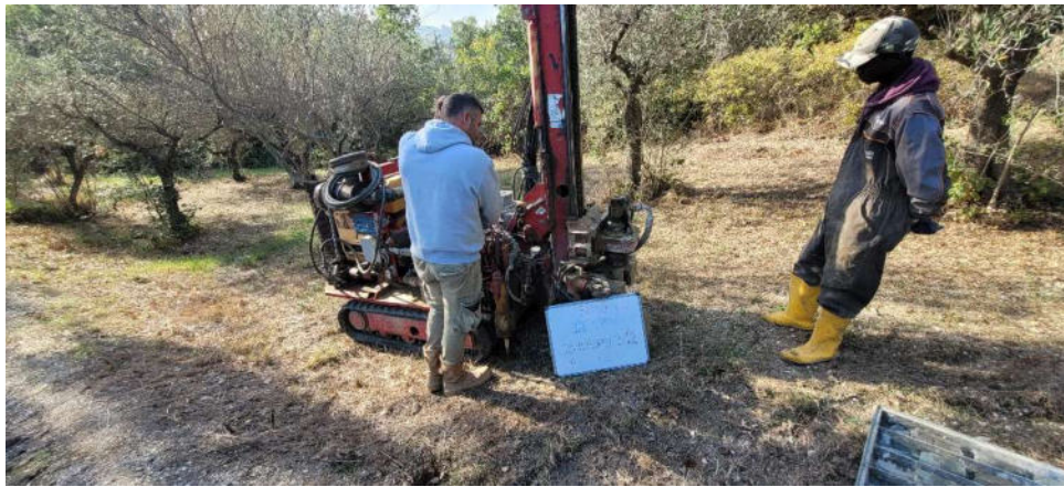
Foto n.1-2 -Approntamento cantiere e postazione sondaggio S12
