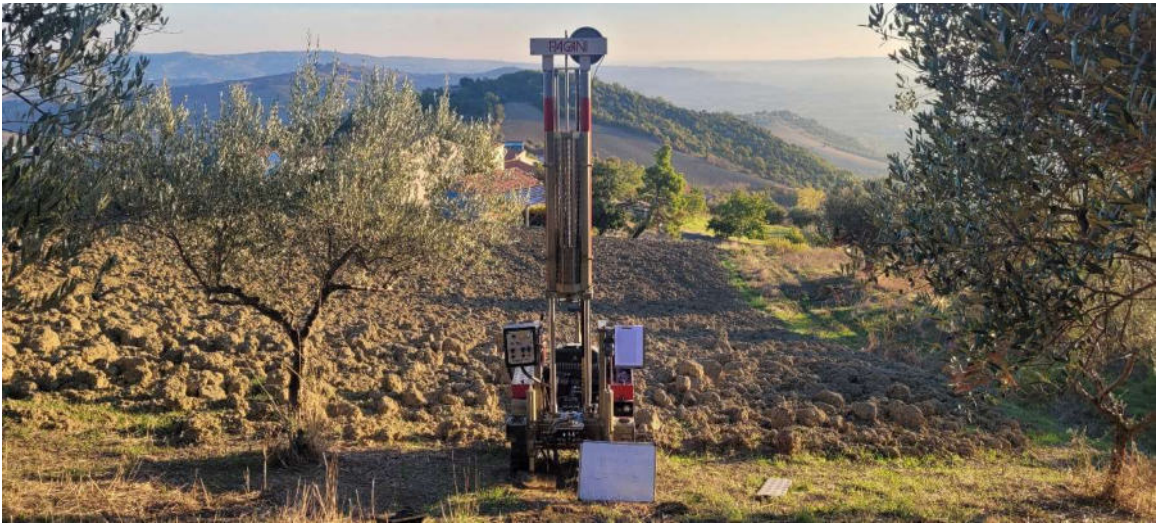
Foto n.6-7- Approntamento cantiere e Postazione prova DPSH P5 .
