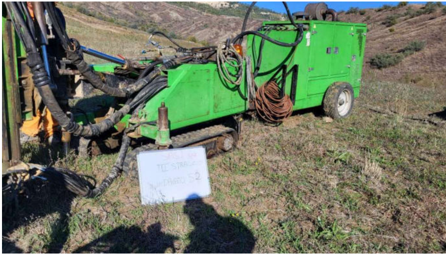
Foto n.5 -Approntamento cantiere e postazione sondaggio S2
