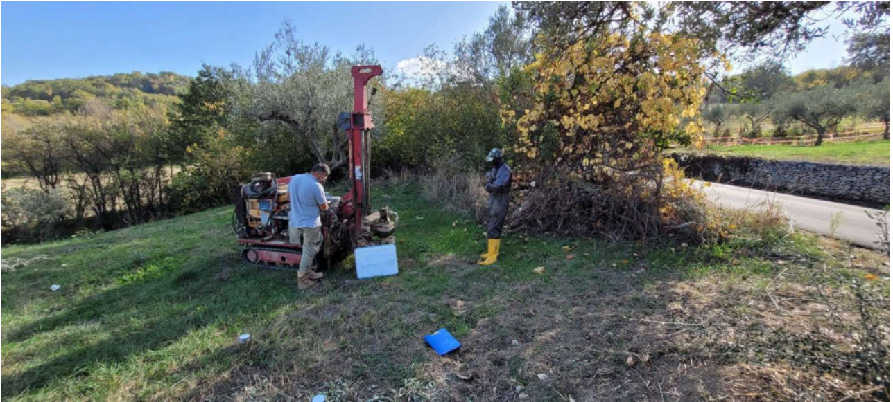
Foto n.14 - Postazione sondaggio S11
