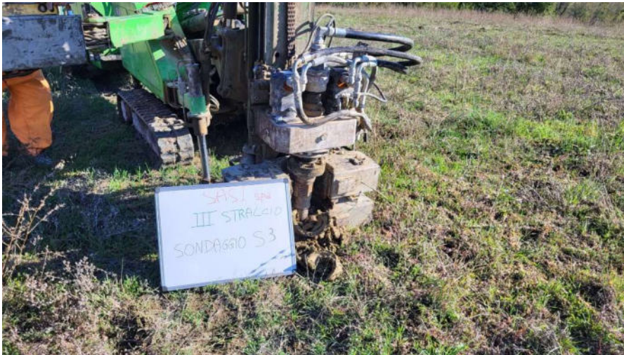
Foto n.8 -Approntamento cantiere e postazione sondaggio S3
