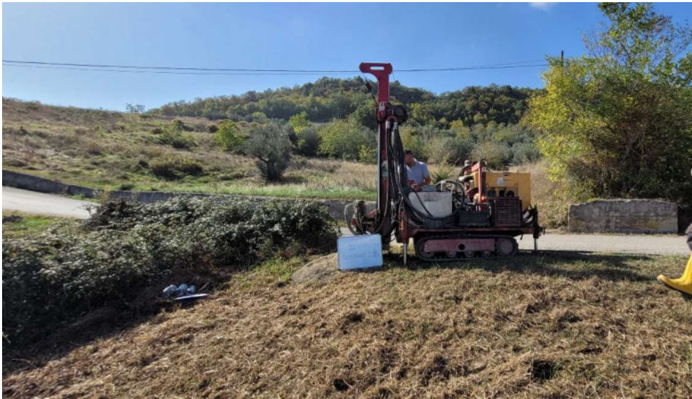
Foto n.10 - Postazione sondaggio S9
