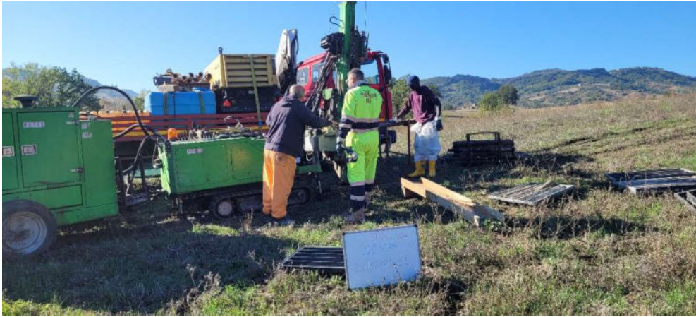
Foto n.11 -Approntamento cantiere e postazione sondaggio S4
