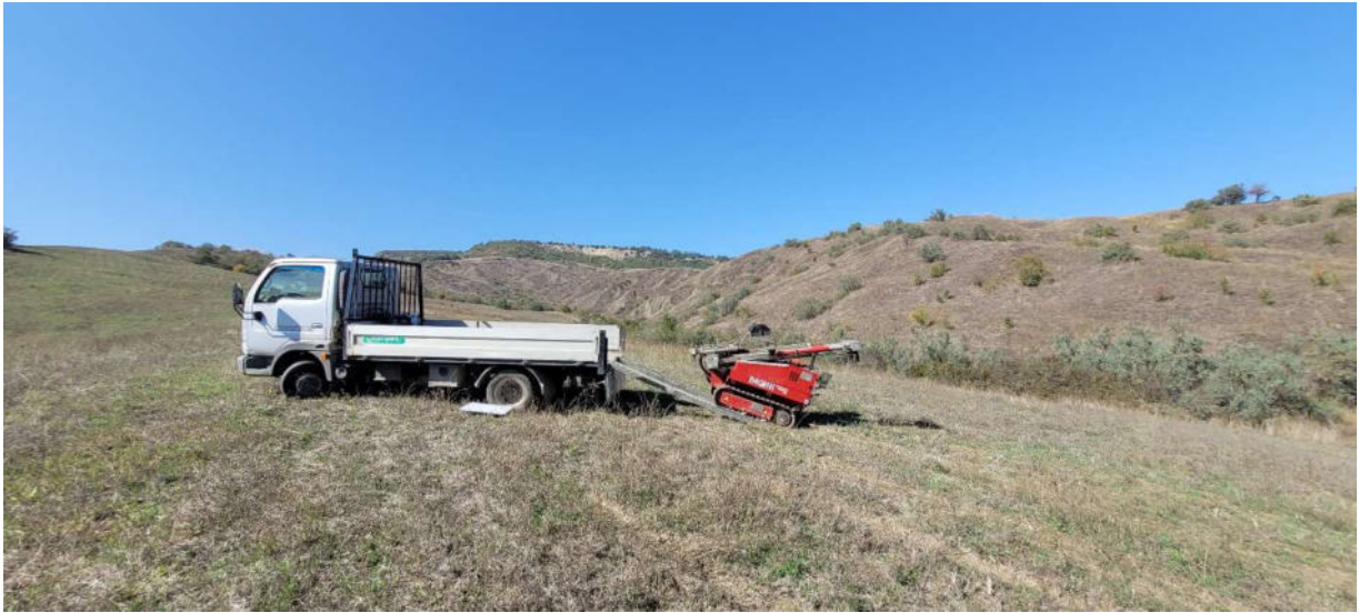
Foto n.1- Approntamento cantiere Penetrometro PAGANI 63TG-100KN.
