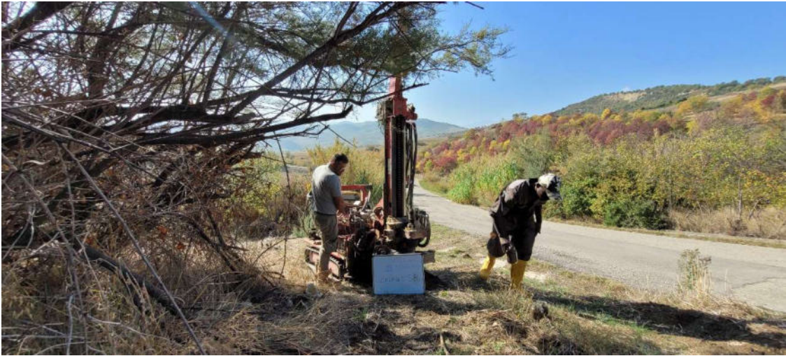
Foto n.8 - Postazione sondaggio S8
