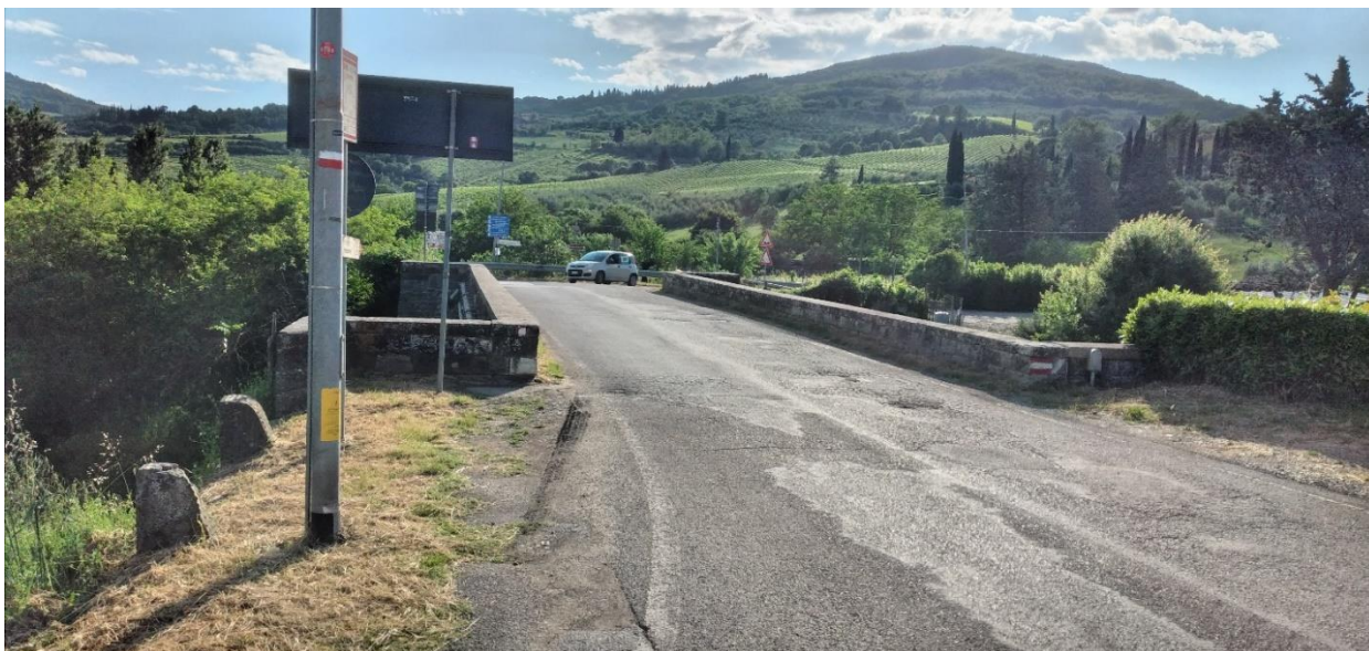
Foto 26 ponte storico - Torrente Argomena
