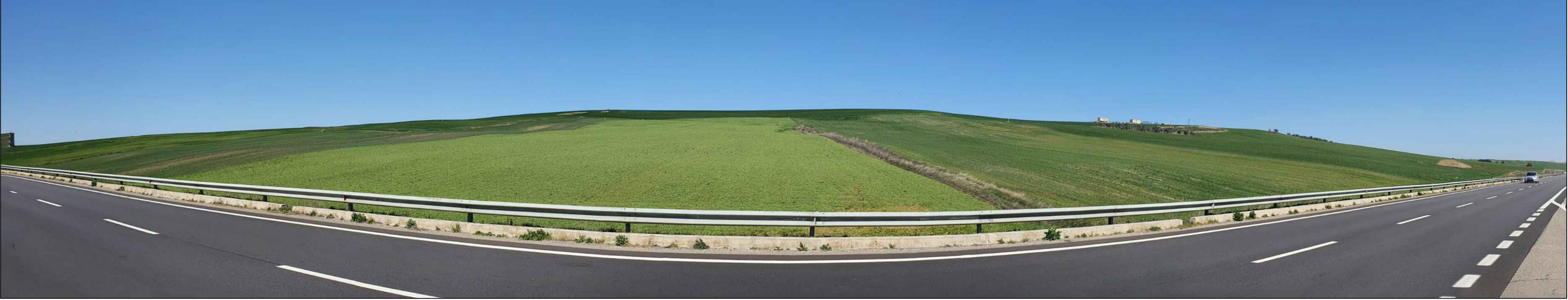
PUNTO 16 - STATO DI FATTO
