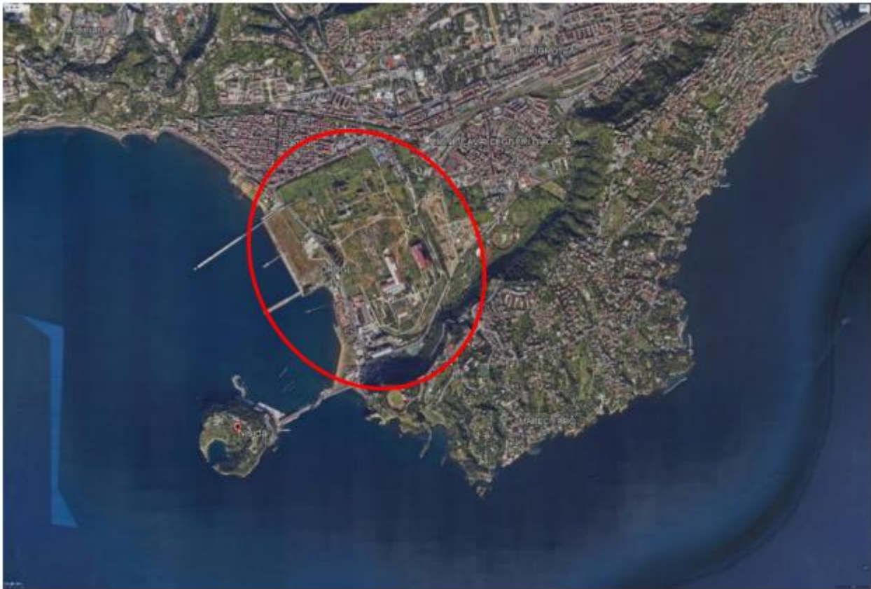
Figura 3-1 Vista dell'area di intervento
