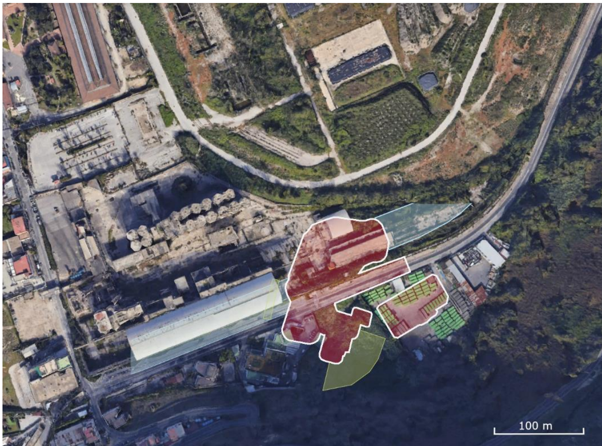
Figura 29 – Sovrapposizione ad immagine satellitare dell'area di scavo complessiva per la realizzazione delle strutture della nuova area impianti, ubicata presso l'ex Cementir e nell'opposto lato di via Leonardi Cattolica. L'area campita in rosso comprende le superfici di scavo di: nuovo impianto di grigliatura media; collegamento HUB di Coroglio; nuovo impianto di sollevamento e pretrattamento; TAF 3. L'area campita in verde è relativa alla superficie dello sbancamento previsto in progetto (approssimata). In azzurro il tracciato del nuovo ASA in entrata ed in uscita dall'area impianti.
