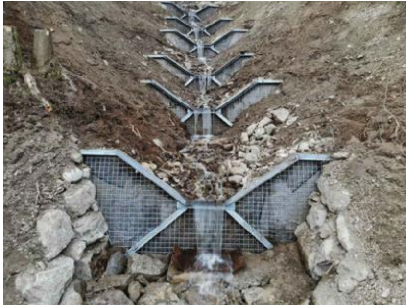
Fig. 19 – Esempio di sistemazione con consolidatore a farfalla
