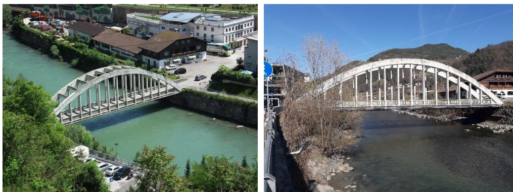
Fig. 3 – Il ponte lungo via Isarco a Ponte Gardena (BZ).
