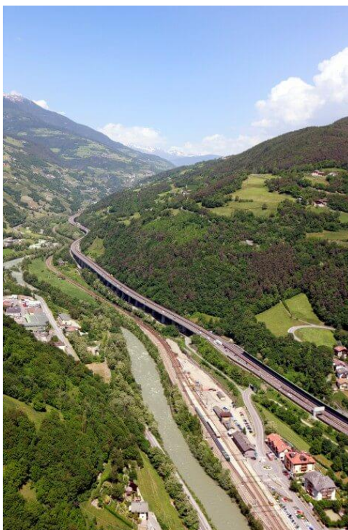
Fig. 2 – Vista aerea dell'area di indagine, si riconosce agilmente l'areale della stazione ferroviaria di Ponte Gardena / Barbiano.
