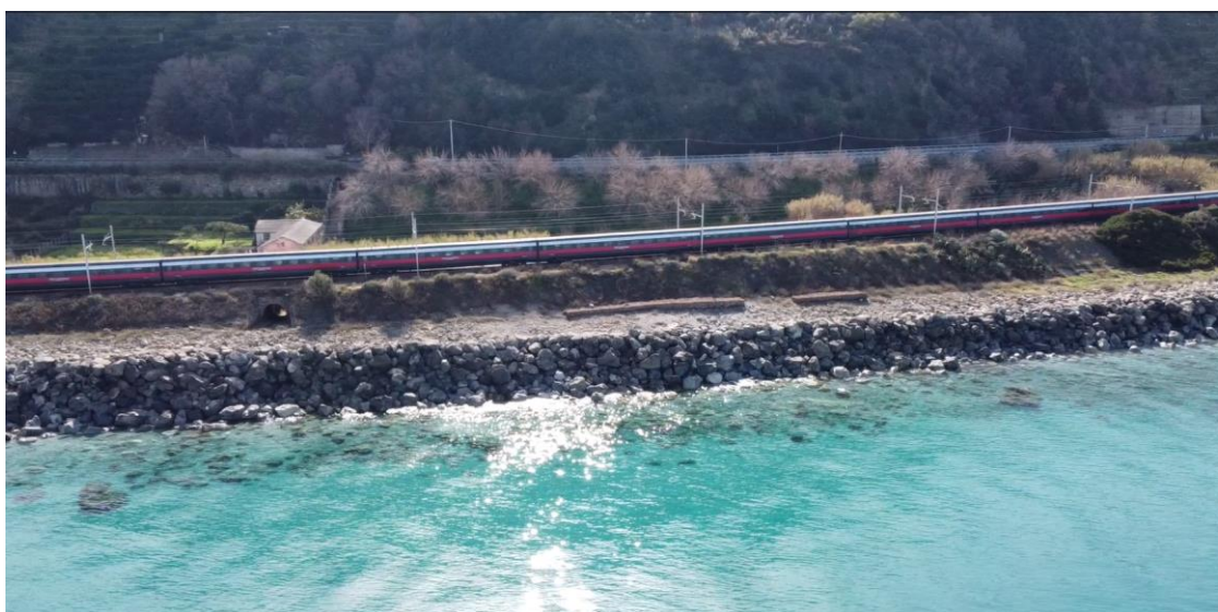
Figura 2-5: Inquadratura della zona con ausilio di aeromobile a pilotaggio remoto (APR). È ben visibile la scogliera radente lungo tutto il tratto di inserimento dell'opera.
