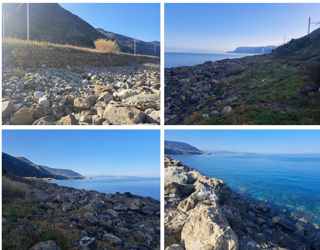
Figura 2-3: Fotografie dell'area. La linea di costa è caratterizzata dalla presenza sia di una barriera radente in opere a gettata rinforzata che da altre opere di consolidamento poste a protezione della ferrovia linea Battipaglia-Reggio Calabria che corre parallela alla SS18.
