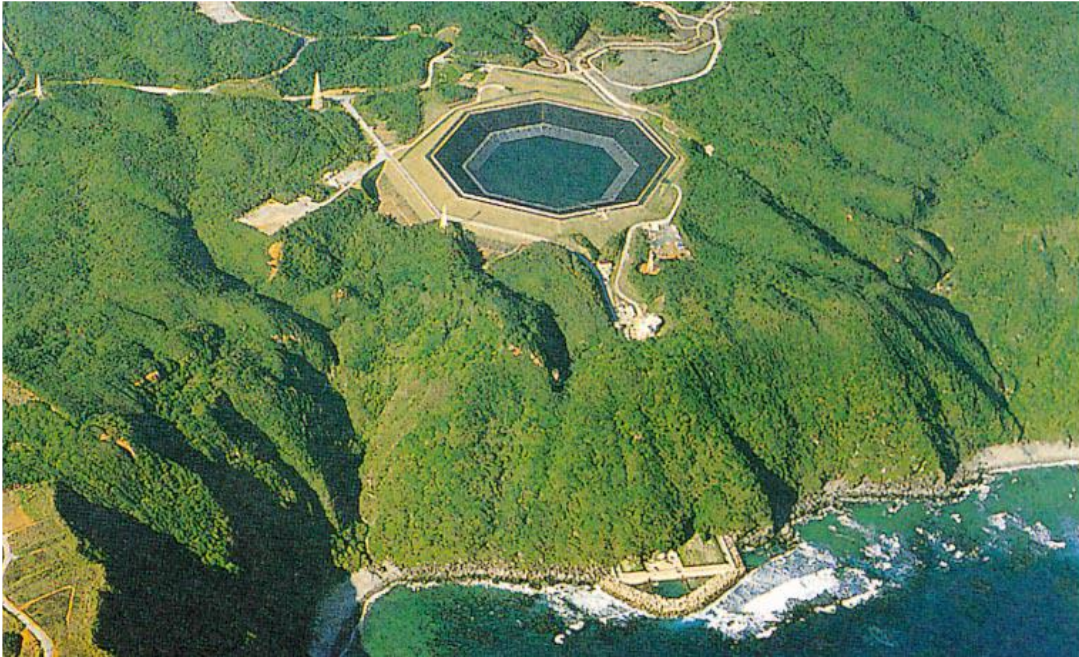
Figura 8-1: Immagine dell'installazione di Yanbaru, sull'isola di Okinawa in Giappone. Ad oggi l'unico impianto di pompaggio alimentato da acqua marina [fonte Hitachi Review Vol. 47 (1998)]
