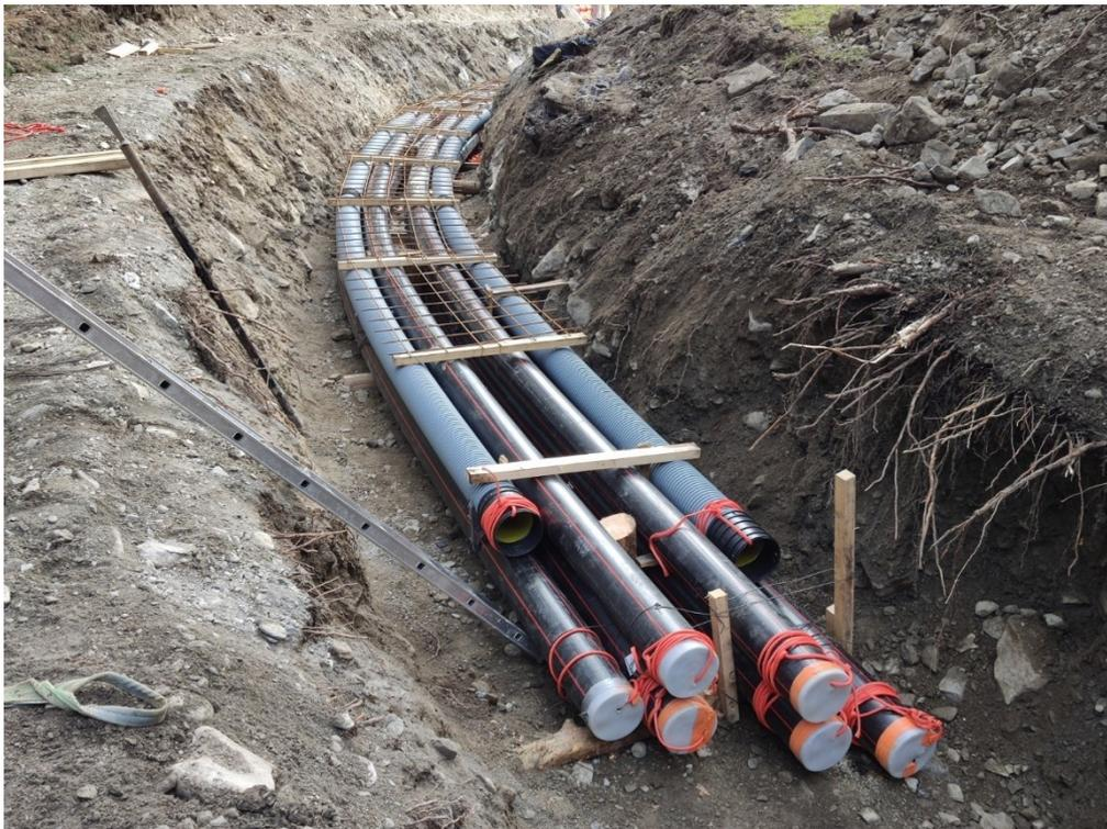
Figura 3.18: Esempio di posa in trincea
