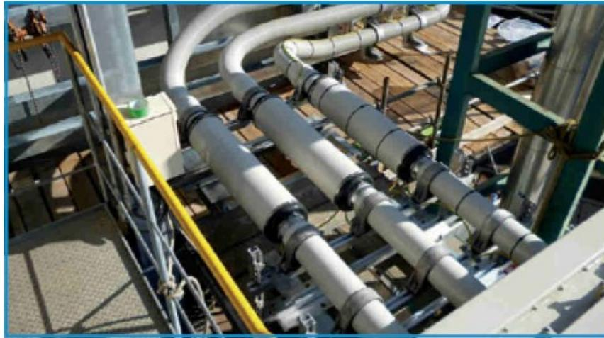
Figura 3.19: Esempio di installazione Sistema IPB (Isolated Phase Bus) – fonte: Duresca ® Bus bar system (Moser Glaser)
