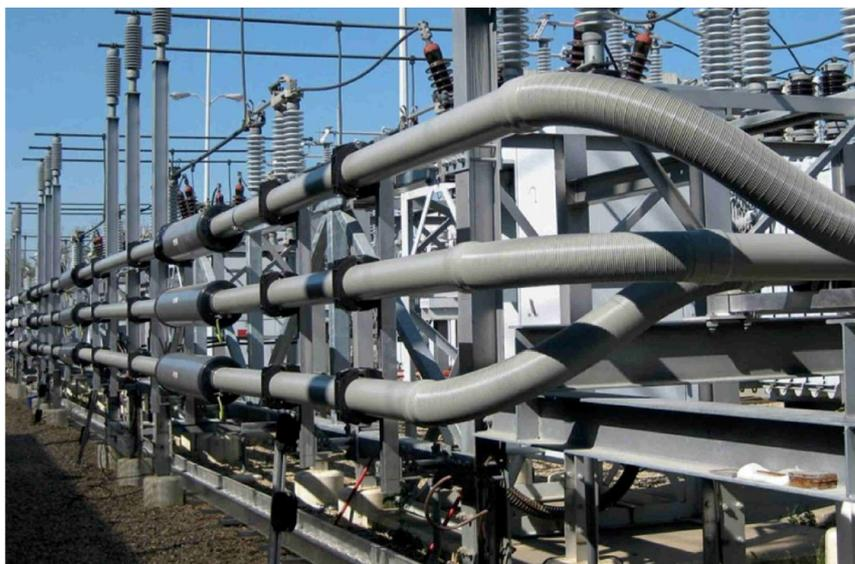
Figura 3.20: Esempio di installazione Sistema IPB (Isolated Phase Bus) – fonte: Duresca ® Bus bar system (Moser Glaser)
