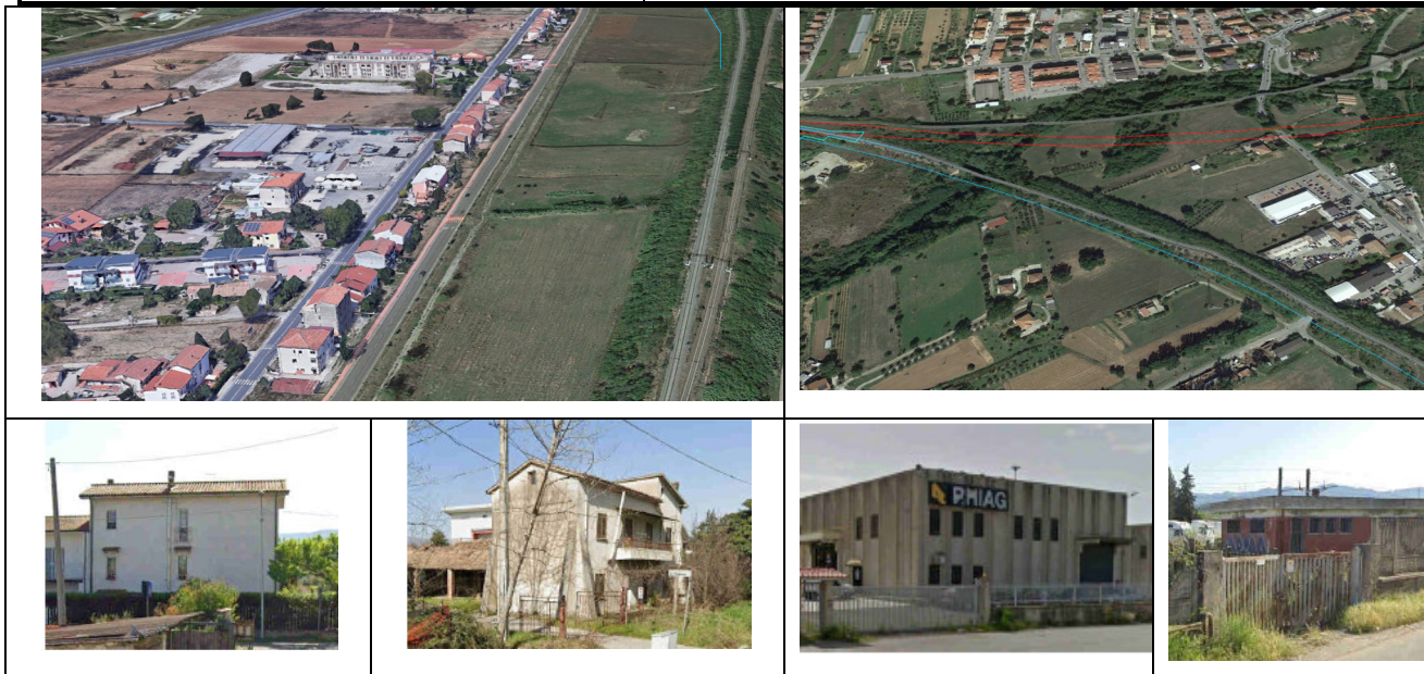
Figura 3-2 Inquadramento area periurbana di Rende, e tipologie costruttive: rilievo fotografico
