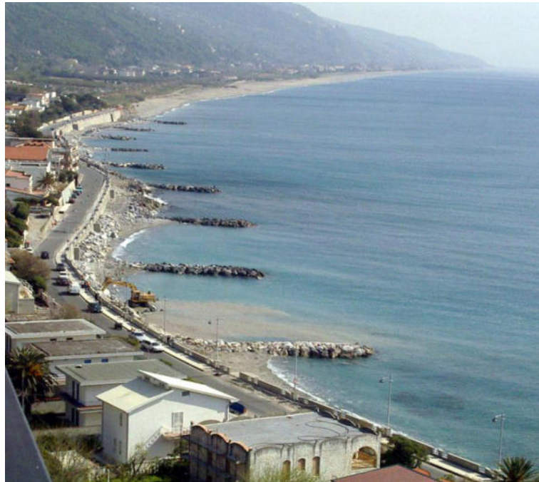
Figura 7-3. Tratta costiera in prossimità di Paola
