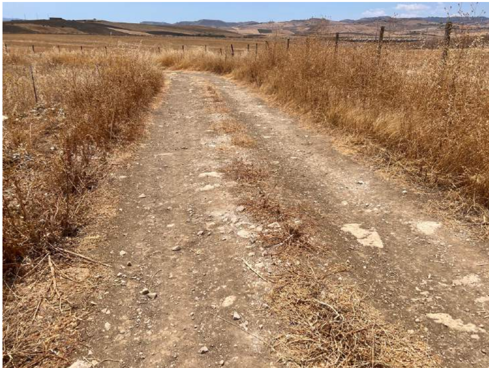
Cavidotto area in direzione delle UURR 8 e 9. Visibile la fattura della strada con pietrame residuale. Area da sottoporre a controllo in corso di intervento
