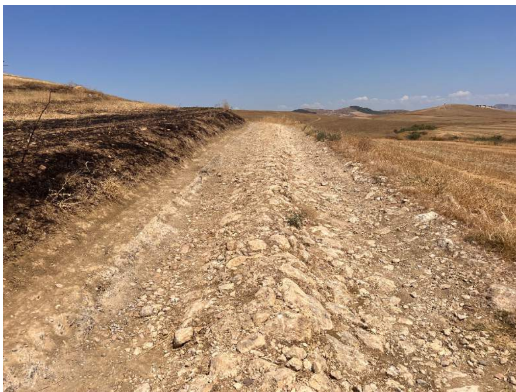
Cavidotto area UR 1. Visibile la fattura della strada con pietrame. Area da sottoporre a controllo in corso di intervento
