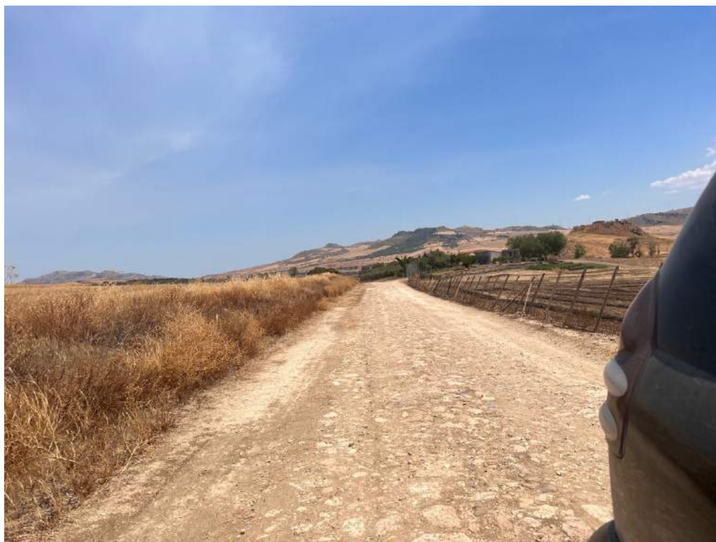
Cavidotto area UR 10 e 11. Visibile la fattura della strada con pietrame. Area da sottoporre a controllo in corso di intervento
