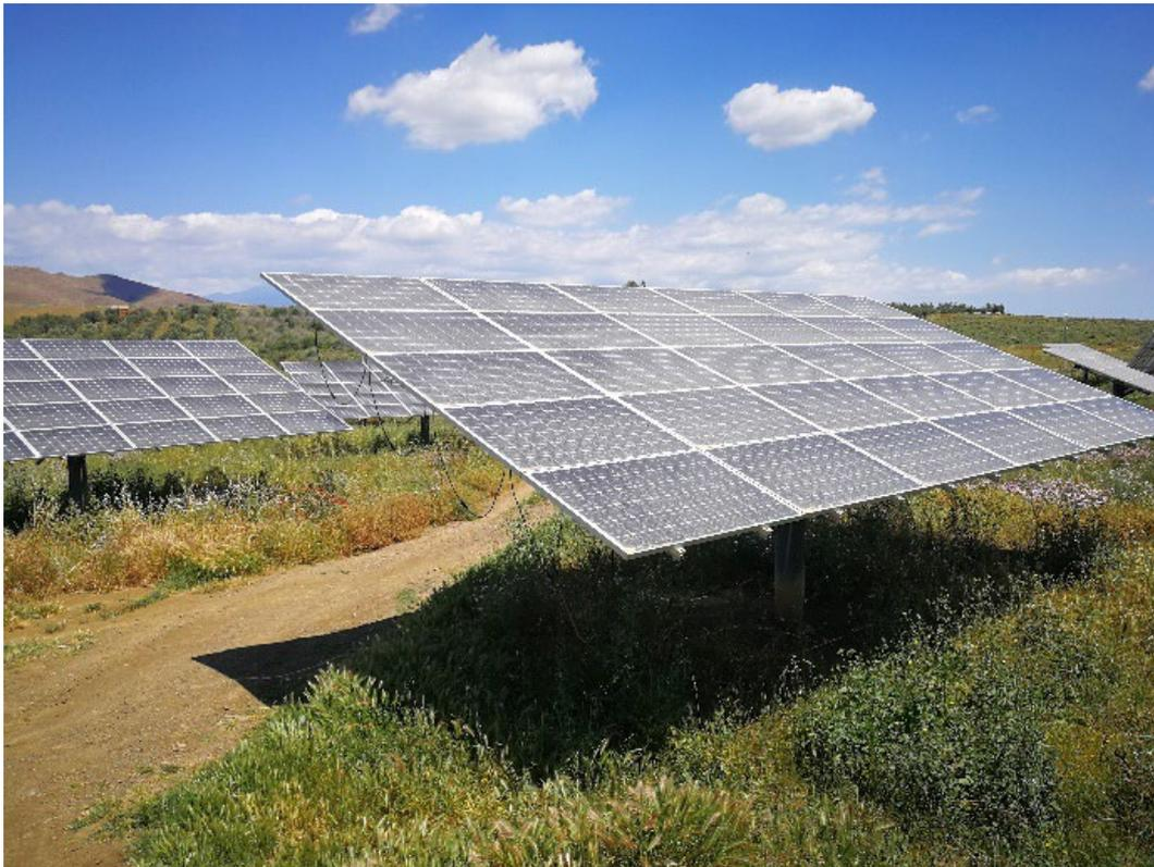
**Figura 6 - Inseguitore biassiale "azimut-elevazione"**
