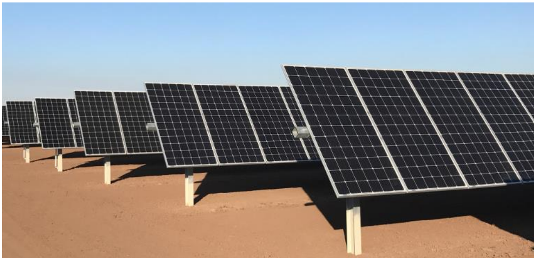
Strutture di supporto "Tracker mono-assiale"
