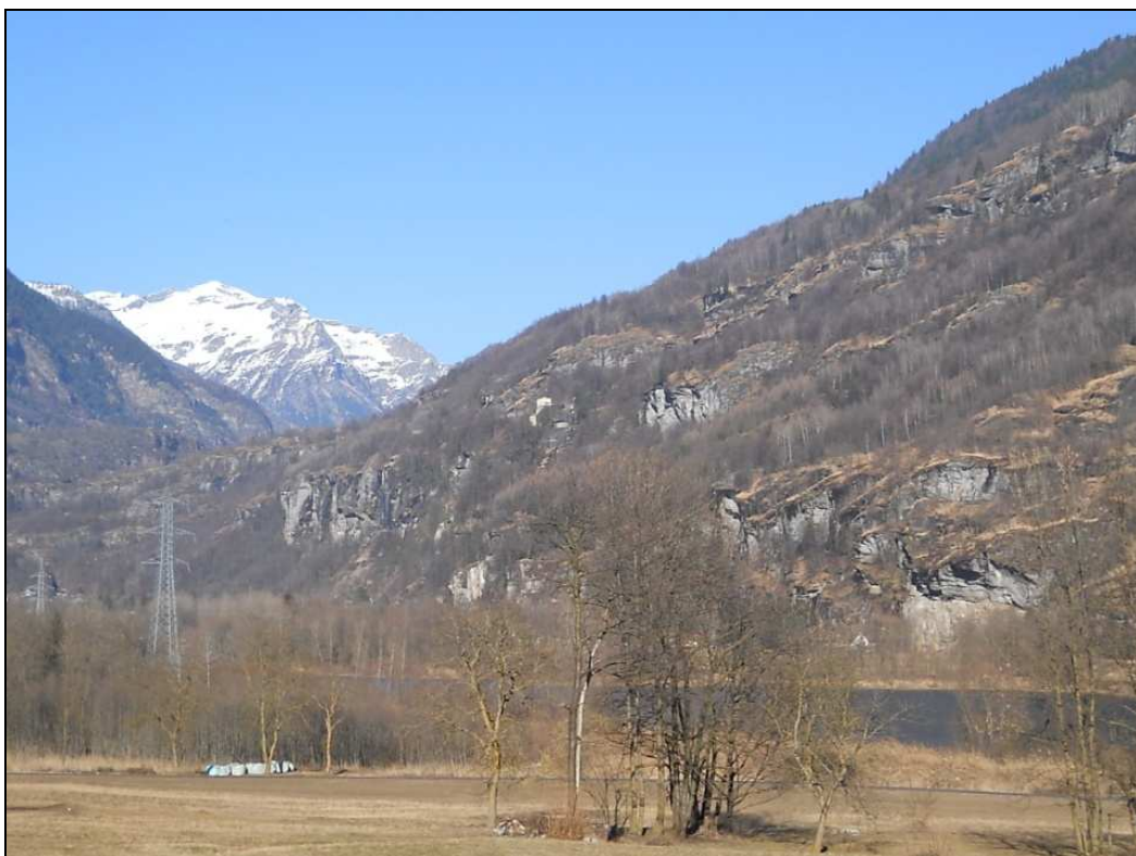
Fig.10. Linea elettrodotto già esistente (da dismettere) all'altezza della conca di Verampio.
