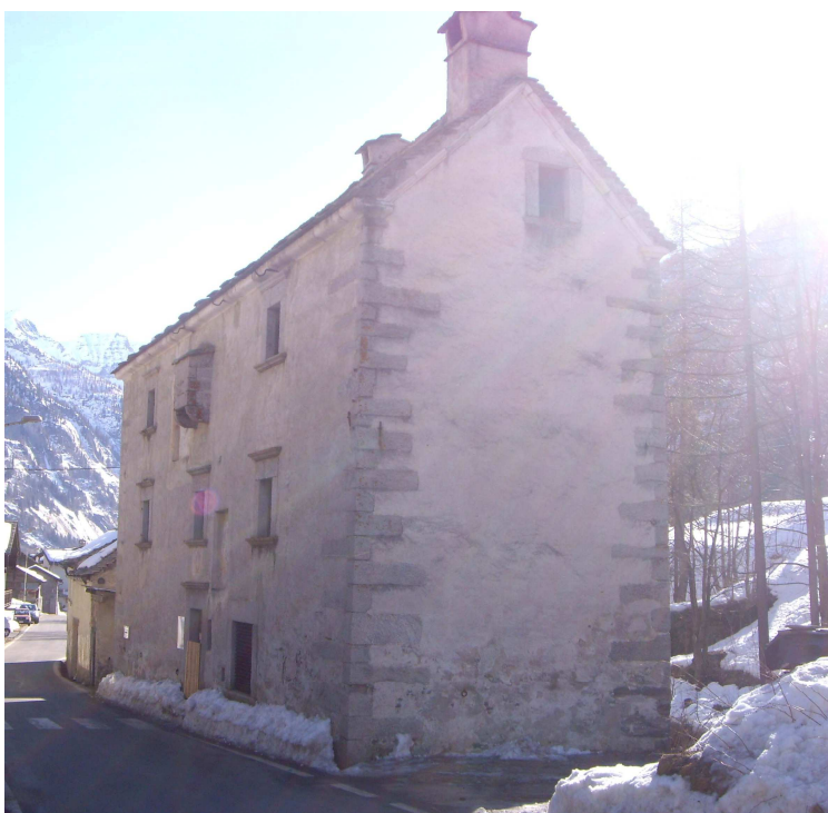
Fig. 7. Comune di Formazza-Ponte. Casa Forte (rif. scheda 5)
