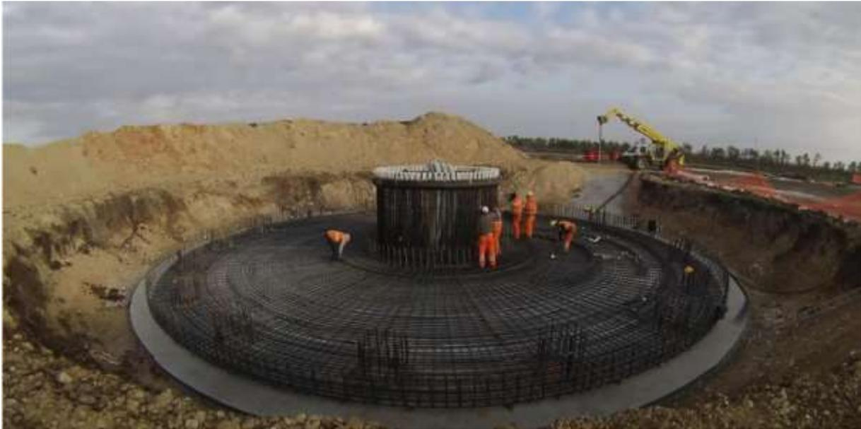
Figura 3—11 fissaggio al basamento della fondazione.
