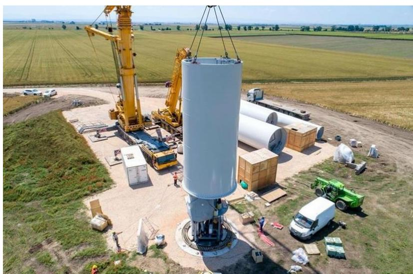
Figure 15 - fissaggio al basamento della fondazione
