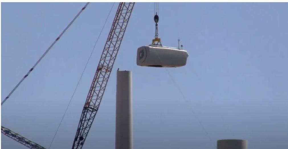
Figure 16 - Installazione navicella
