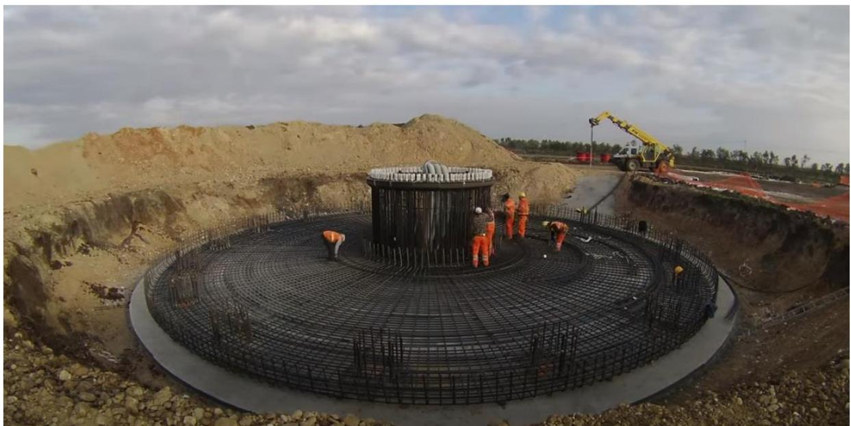
Figure 14 - Predisposizione del plinto di fondazione
