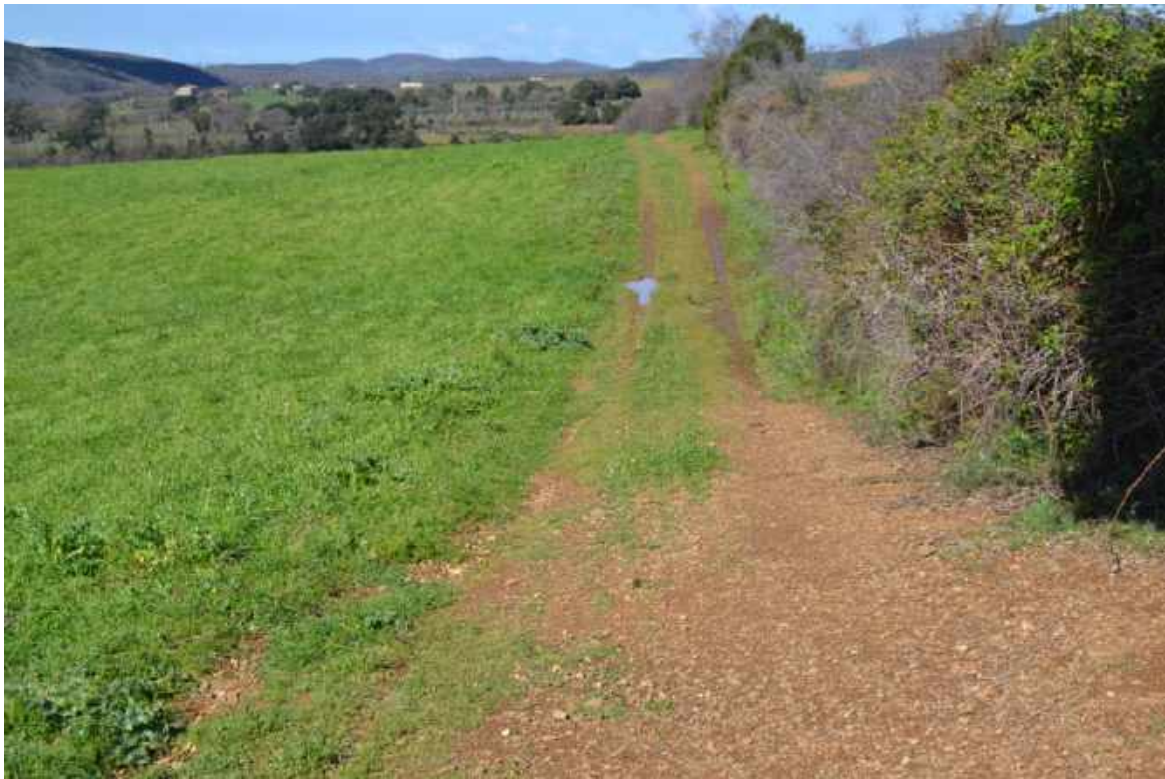
Figura 20 – cavidotto di WTG 2 in prossimità del futuro aerogeneratore
