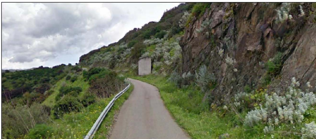
Figura 10: Area oggetto di intervento impostata su una morfologia collinare – Settore interessato in prossimità del picchetto P04 – P05
