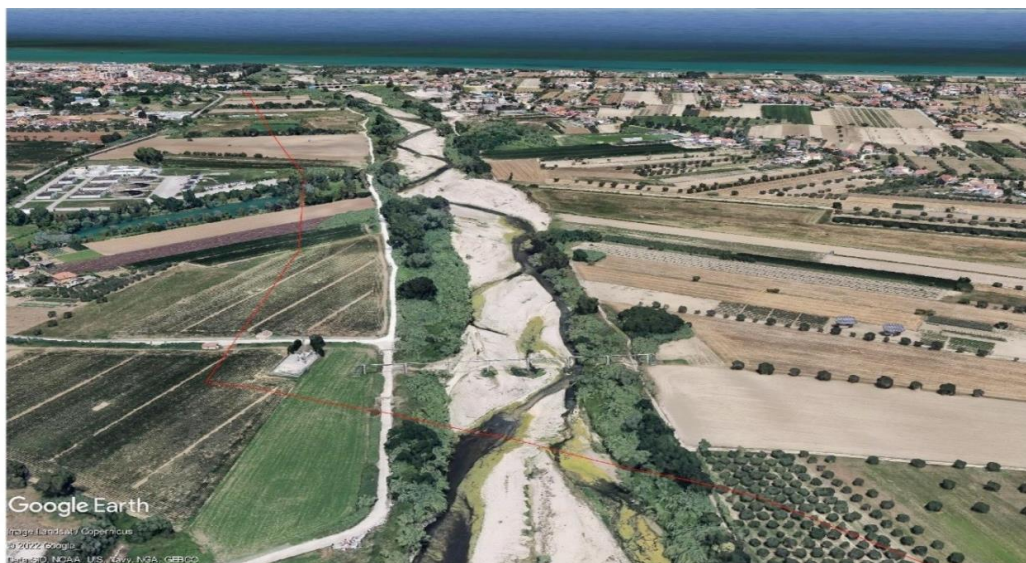
Figura 1-4. Attraversamento fiume Tordino
