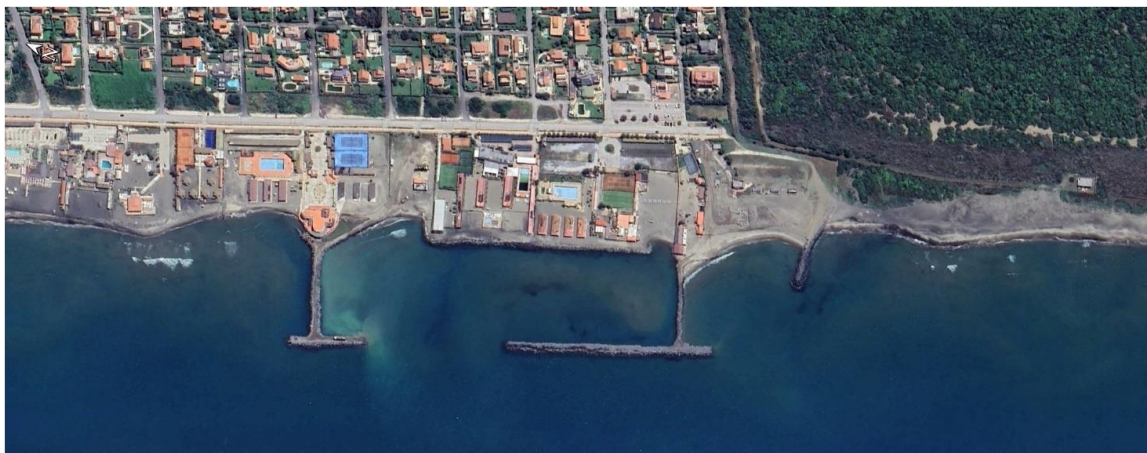
Figura 3.52: Foto aerea dell'intervento di difesa costiera finanziato dal Comune di Fiumicino; stato di realizzazione a maggio 2023
