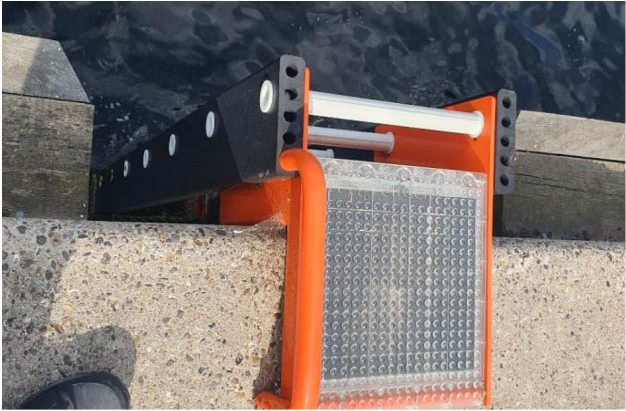
Figura 3.34: Scaletta di risalita autoilluminante
