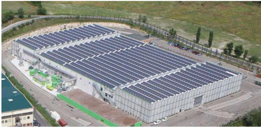
Figura 3.72: La soluzione mitigativa proposta per eliminare l’effetto attrattivo esercitato dall’ampia superficie piana dei tetti degli edifici previsti dal Piano, prevede l’utilizzo di pannelli fotovoltaici. L’immagine raffigura un capannone di un impianto in Emilia Romagna.
