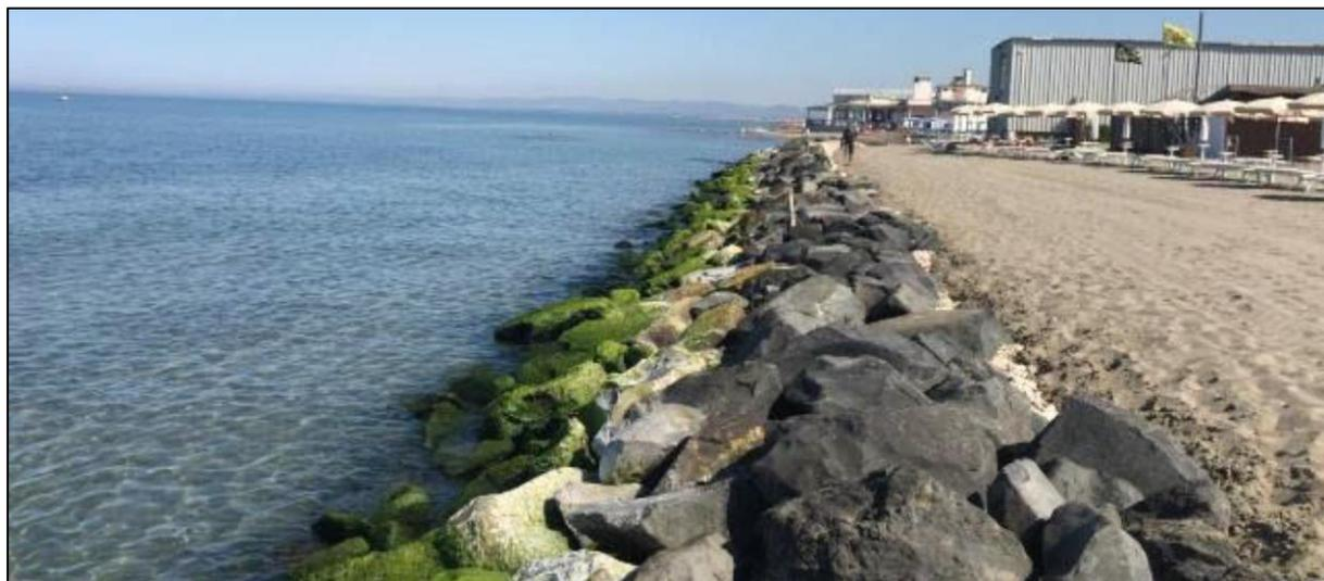
**Figura 3.16: Opera di difesa in massi naturali eseguita nel luglio 2020 a Fregene**
