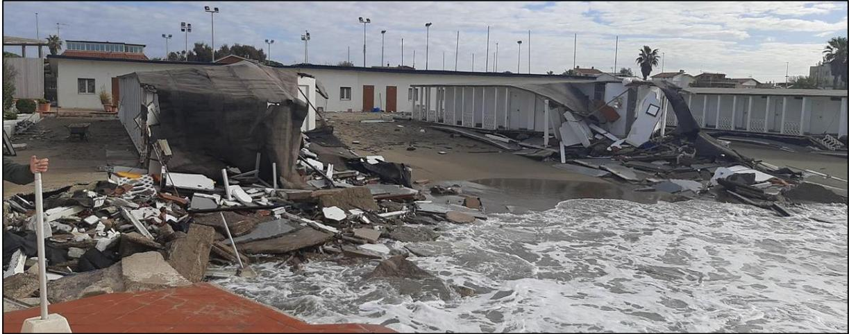
Figura 3.21: Crollo delle cabine de La Nave a seguito delle mareggiate dell'inverno 2022; foto n. 2.
