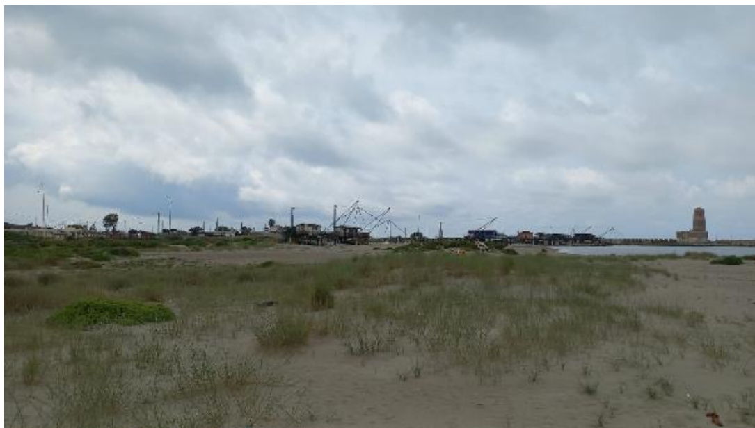
Figura 4.8: Panoramica tratto di costa che si raccorda al promontorio del faro
