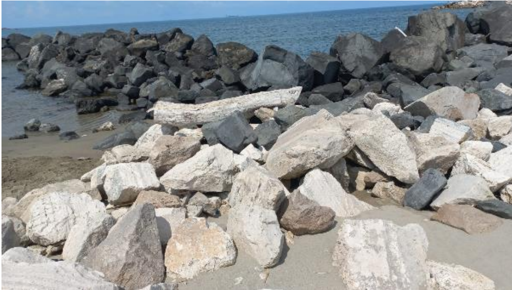
Figura 4.13: Blocchi costituenti le barriere di protezione antierosione
