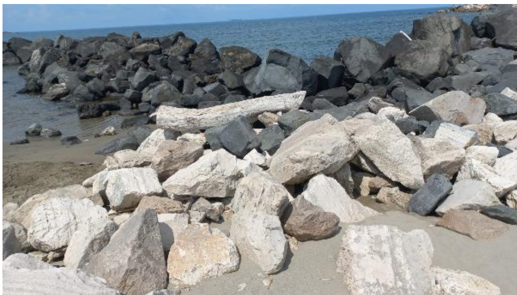
Figura 3.7 - Blocchi costituenti le barriere di protezione antierosione
