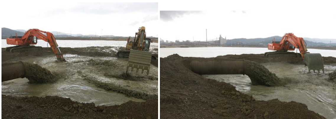
Figura 5-14: Gestione del materiale di dragaggio nelle aree con riempimento in acqua
