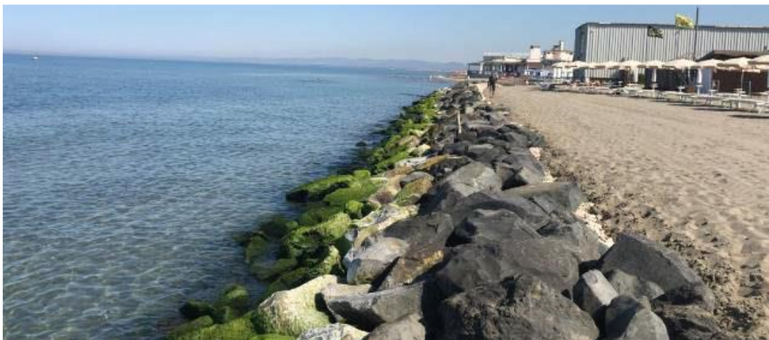
Figura 16 - Opera di difesa in massi naturali eseguita nel luglio 2020 a Fregene.
