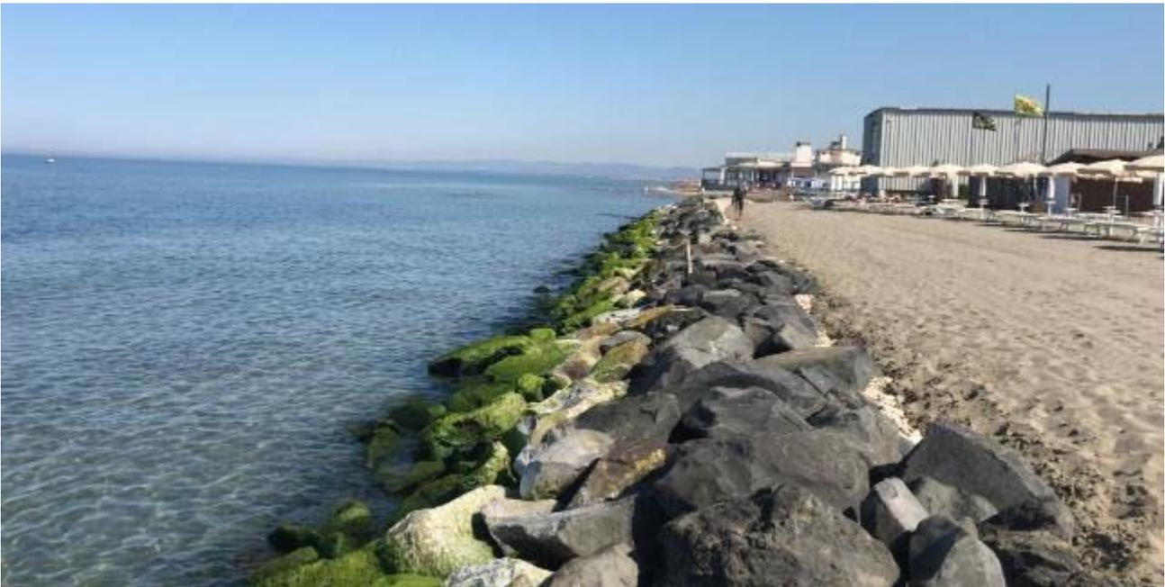
**Figura 7 - Opera di difesa aderente realizzata in urgenza nel 2020**
