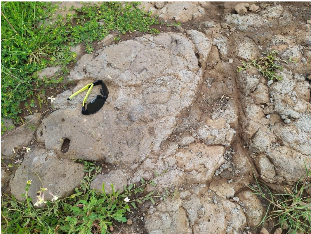
Figura 5.11 - Trachibasalti della Subunità di Funtana di Pedro Oe, molto fratturati, parzialmente alterati, con fratturazione irregolare, posti a circa 490 m dalla WTG M2_08
