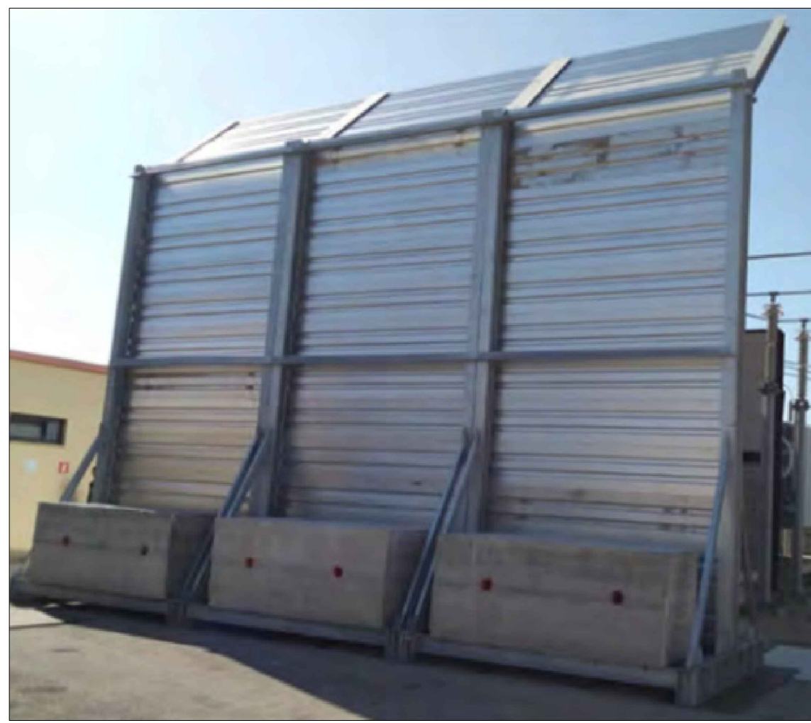
BARRIERE ANTIRUMORE PER CANTIERE BASE H= 3,00/ 5,00 mt
