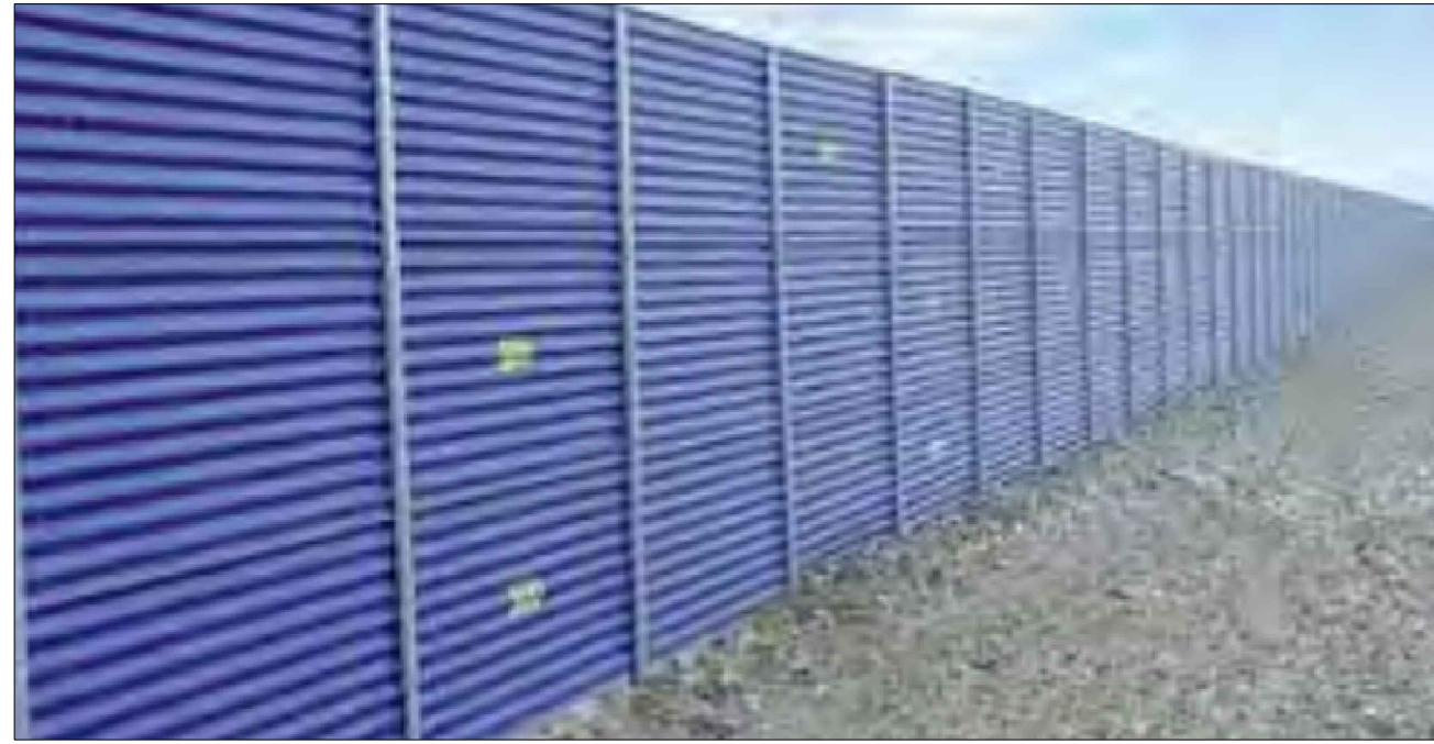
RECINZIONE DI CANTIERE BASE - H= 3,00 mt
