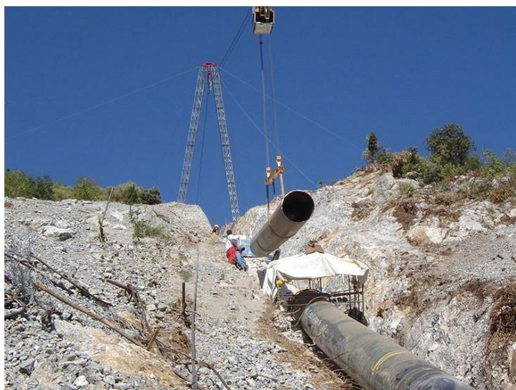
Figura 9 - Sistemi di gru a fune
