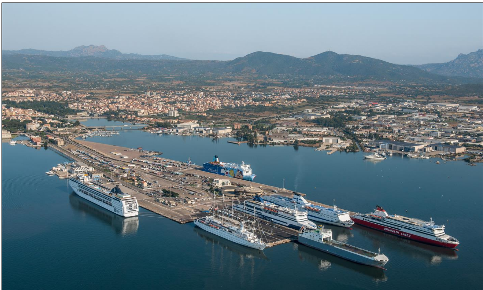
Figura 105. Vista aerea dell'area portuale con drone (anno 2018)
