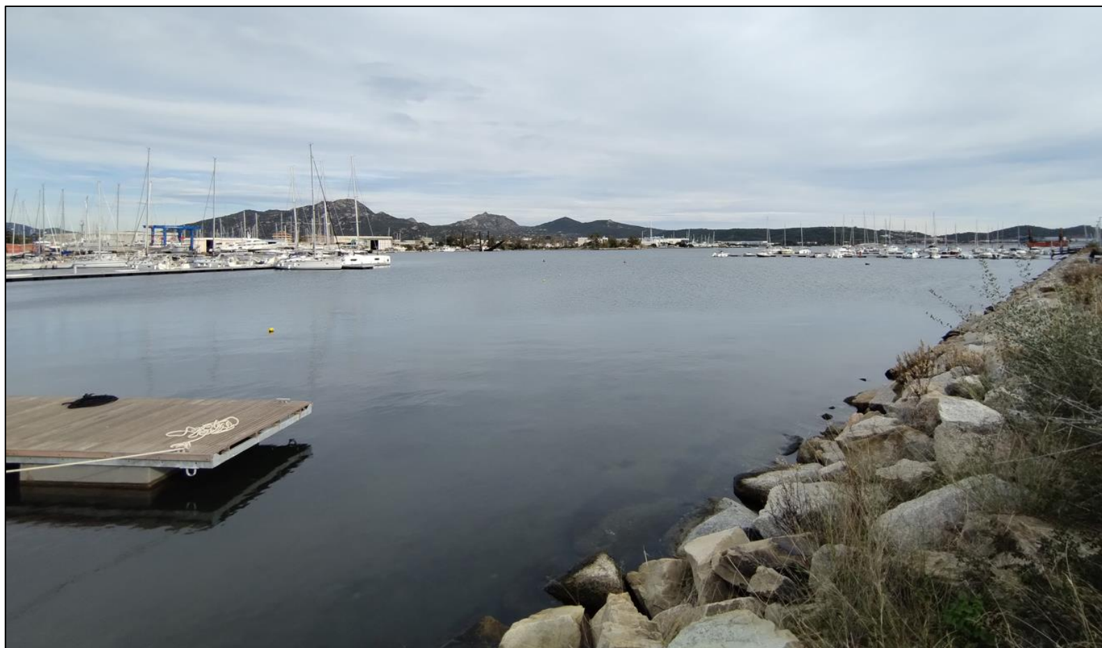
Figura 110. FOTO B – Stato attuale
