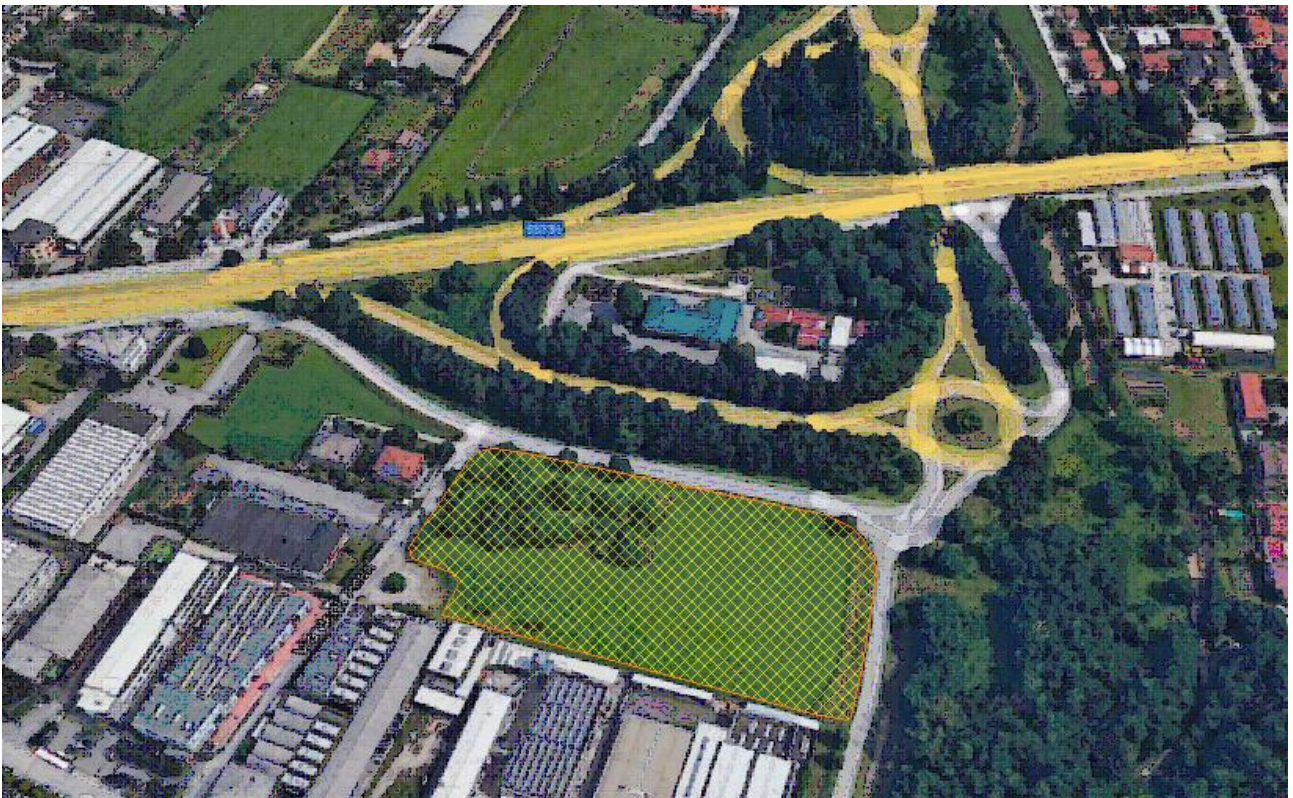
Foto 5-3: vista aerea cantiere operativo C.03
