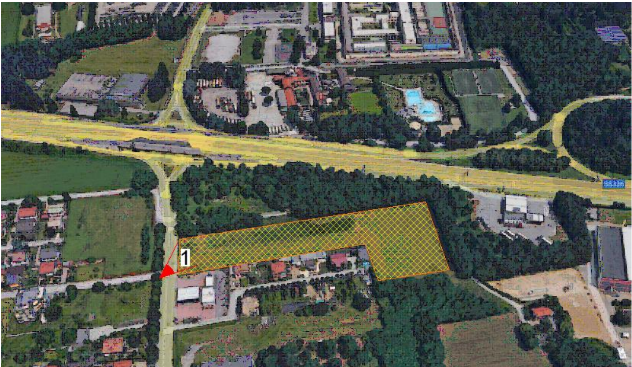
Foto 5-2: vista aerea cantiere operativo C.02
