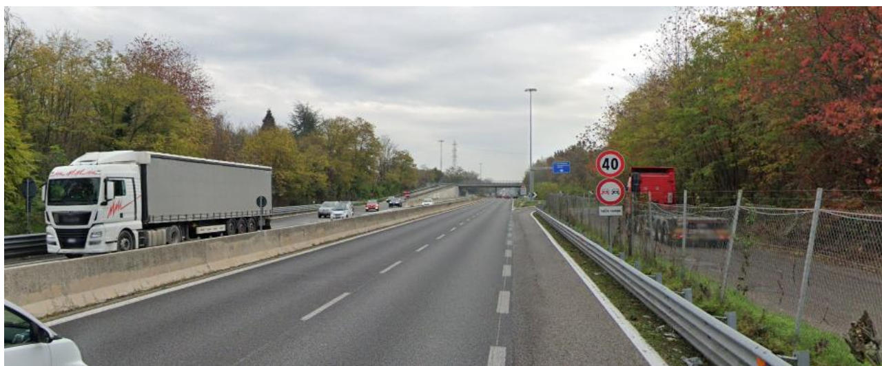
Figura 7.1.1-7: Immagine dello stato di fatto nel secondo tratto della SS336
