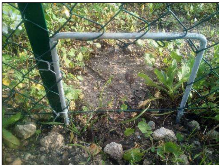
Particolare dei passaggi fauna
