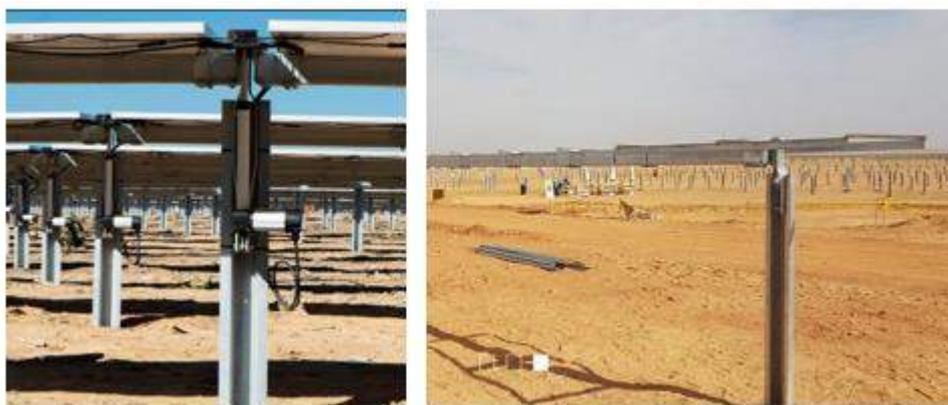
Figura 8. Particolare strutture ad inseguimento ed attuatore
