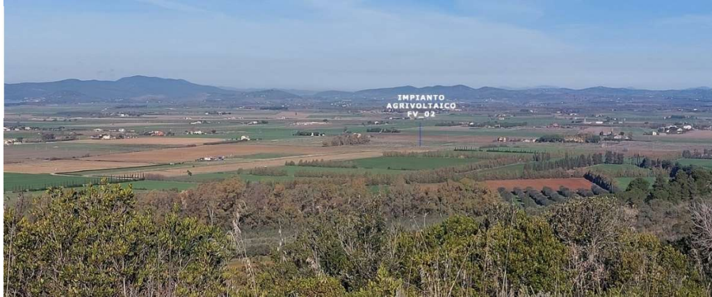
Punto visivo F03 ante operam
